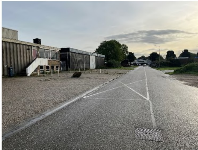
Foto 17: overzicht foto 6 asfalt
