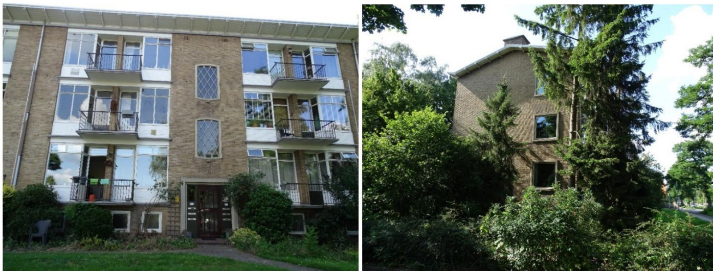
Figuur 2: Foto's van het plangebied Diedenweg te Wageningen (Laneco, 2023).
