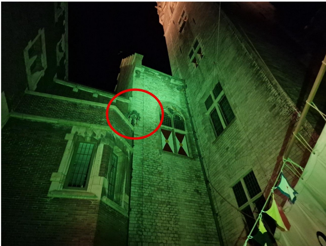
Binnenplaats met in de rode cirkel het vleermuisverblijf.
