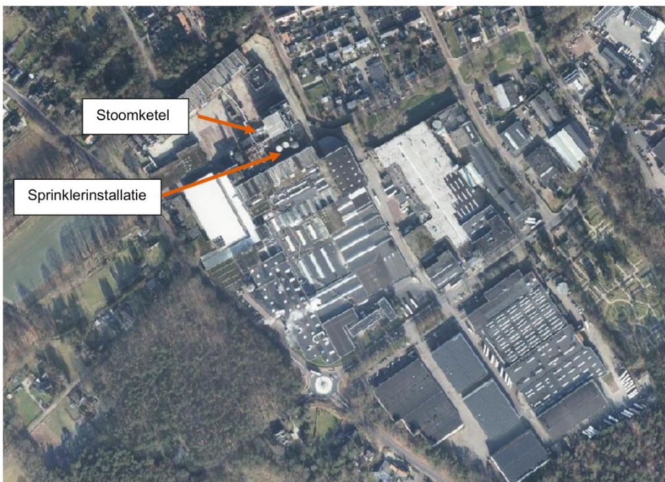
Afbeelding 6: huidige locatie stoomketel en sprinklerinstallatie (bron: Pdoc, bewerkt door Arcadis)
