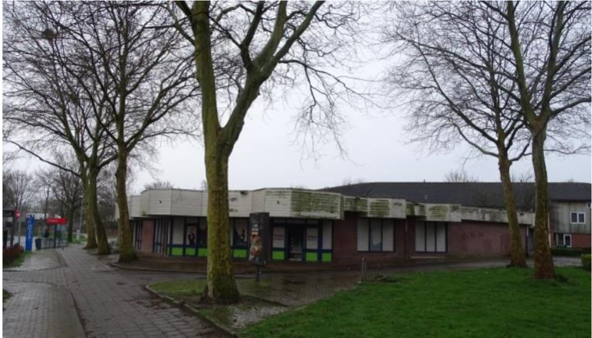
Afbeeldingen: huidige situatie projectlocatie
