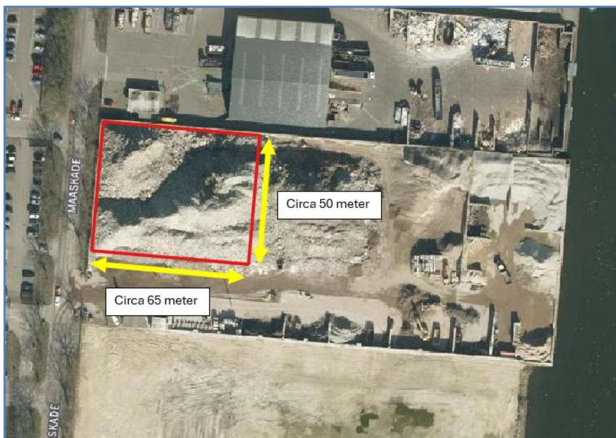
Afbeelding 3. Opslag mengpuin & betonpuin met een permanent benodigde hoogte van 5,0 meter
