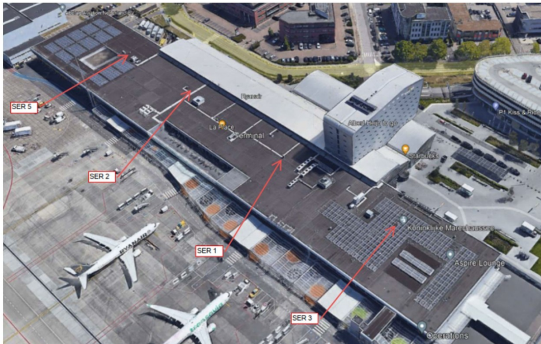
Figuur 2.4 Locatie 4 koelinstallaties Western Datatech ten behoeve van de SER ruimtes 1,2, 3 en 5 op het dak van de terminal
