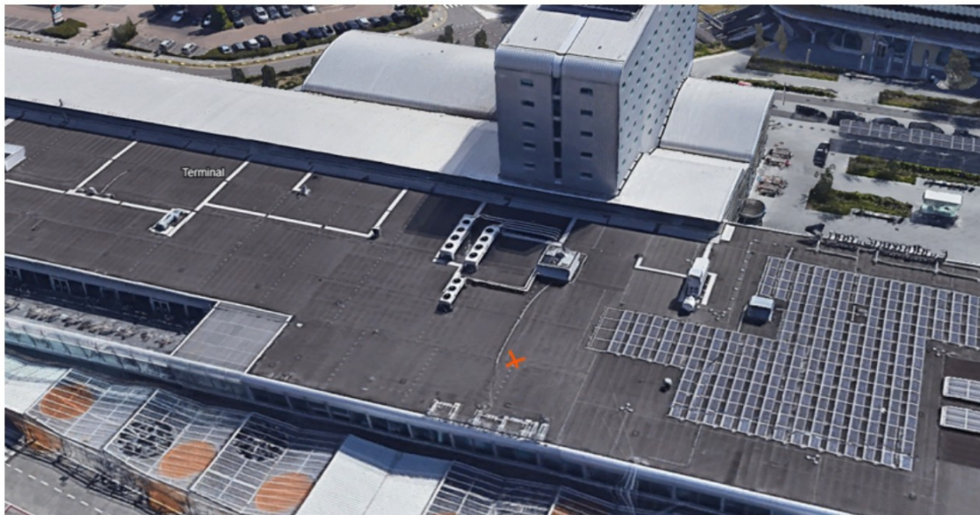
Figuur 2.6 Locatie koelmachine RAS-B13E2KVG-E/RAS-13E2AVG-E ten behoeve van een SER ruimte op het dak van de terminal
