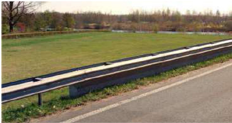
Figuur 4.4: Voorbeeld geluidgeleiderail (Foto: Cyclomedia)
