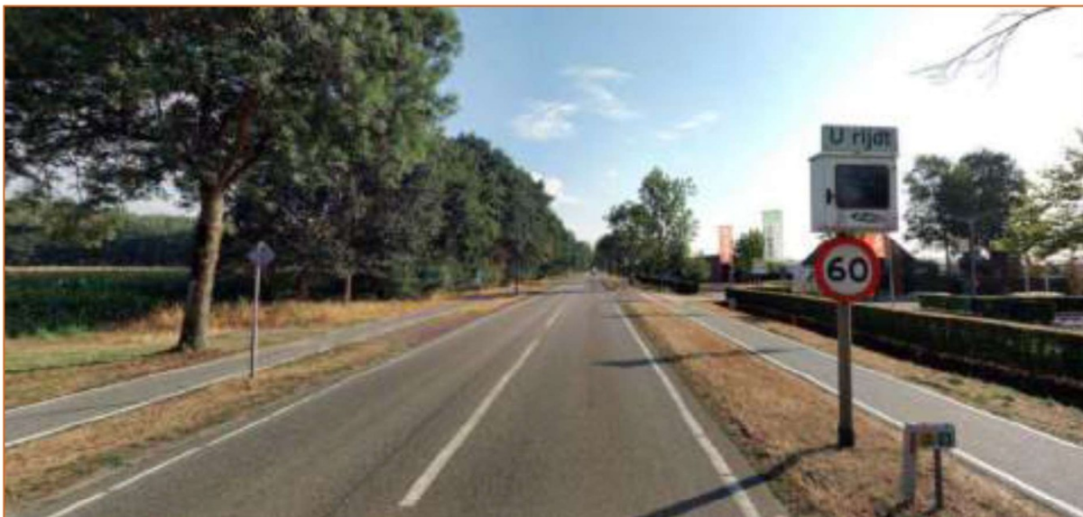
Foto 2-1 Uiterlijk dwarsprofiel N615
