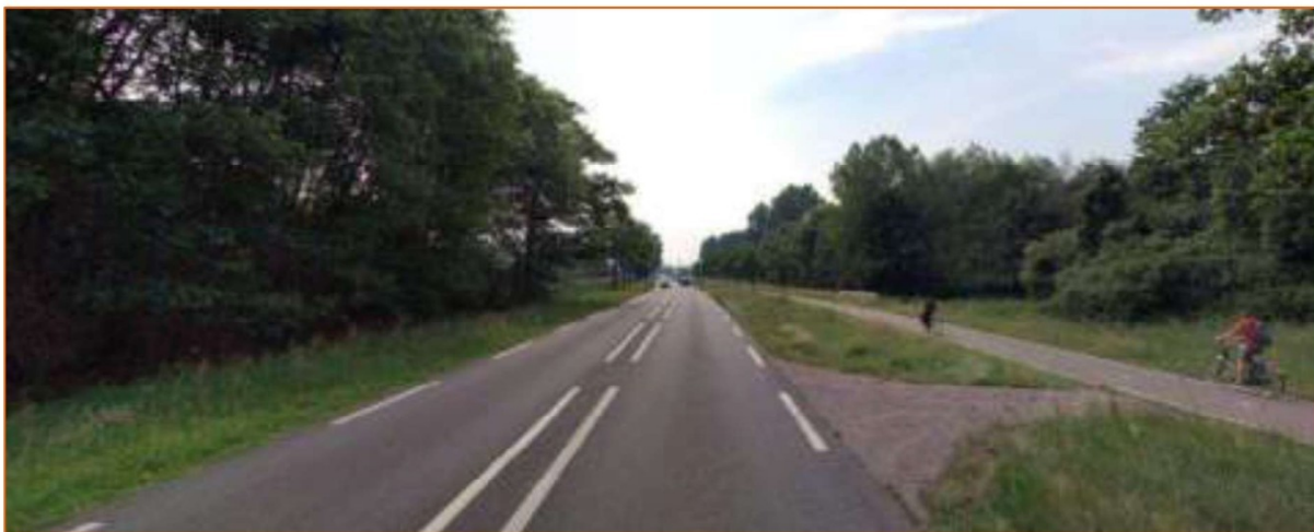
Foto 2-2 Uiterlijk dwarsprofiel N272
