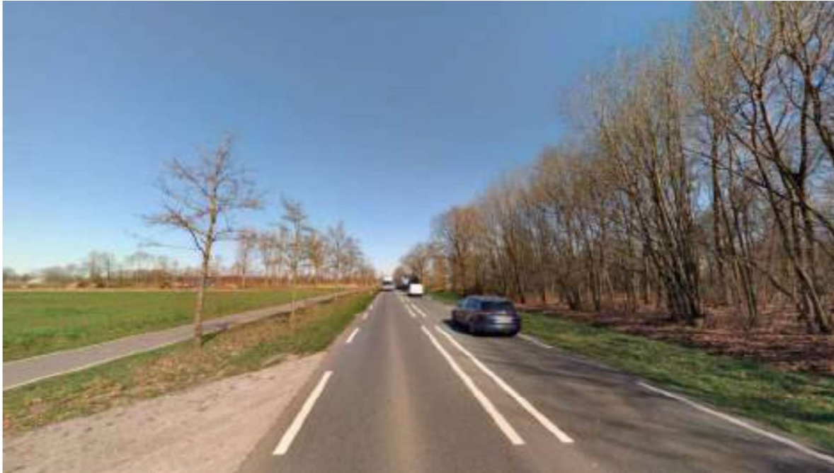
Foto 3 Aantasting van de bomenrijen en een bosperceel door de reconstructie van dit wegdeel van de N272.
