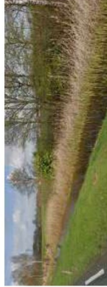
Figuur 6.18: Voorbeeld watergang met maalbaar talud, plasmazone en reibewer Hortelsloep
