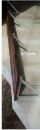
Figuur 6.16: Voorbeeld passeerbare booplaak van een ecopassage
