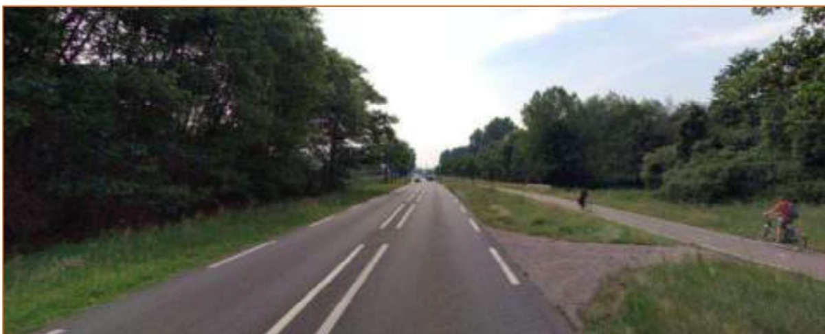
Foto 2-2 Uiterlijk dwarsprofiel N272
