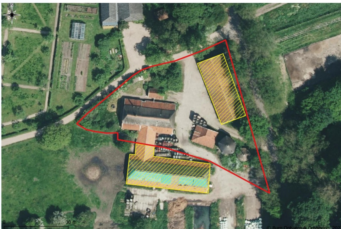
Figuur 1. Luchtfoto van grenzen waarbinnen de herinrichting van Velhorst 3 plaats zal vinden (rood kader). Een deel van de bebouwing is reeds gesloopt of verplaatst en is op deze kaart aangegeven met gele diagonale strepen.
