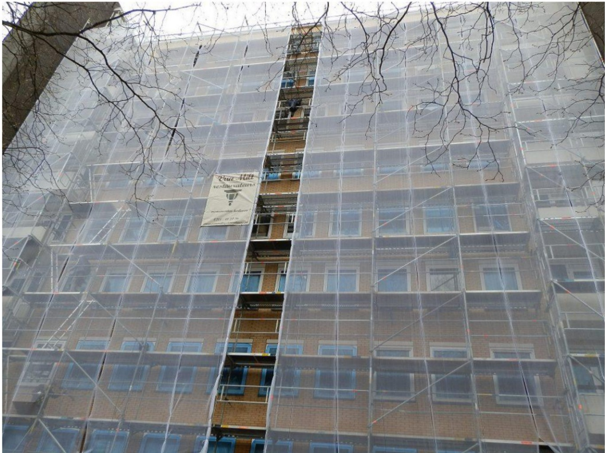
Afbeelding 10: Voorbeeld van 50% wind reducerend steigergaas (JSSteigerbouw, 2025).
