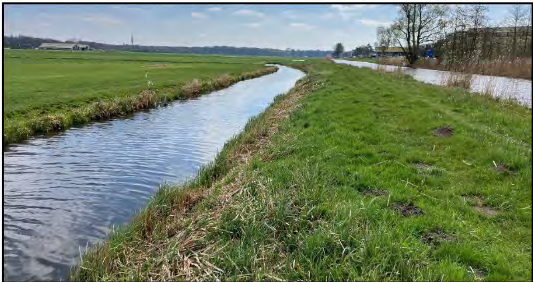
Afbeelding 11. Steile taluds van de teensloot. Oostelijk is de 's-Gravelandse Vaart te zien.
