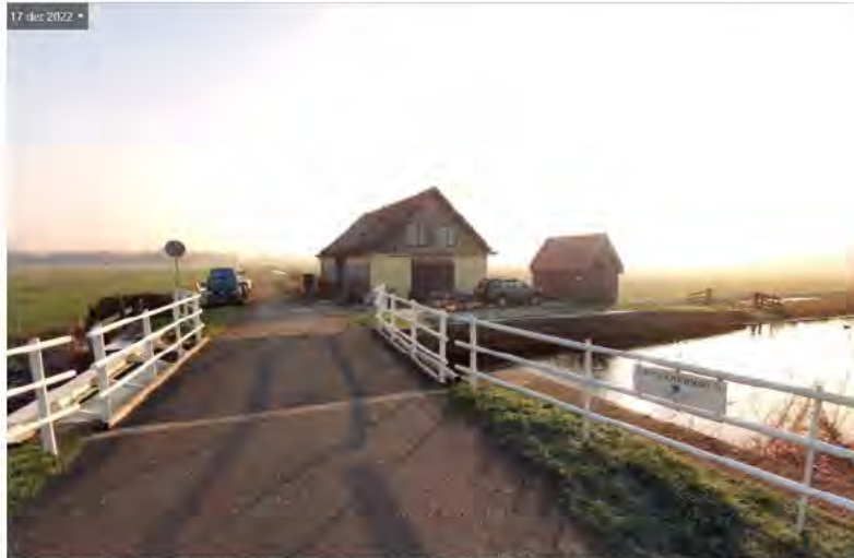
Figuur 4-22: Maatwerklocatie Erfgooiersbrug en opstal en gemaal KGM00412 in het achterland.
