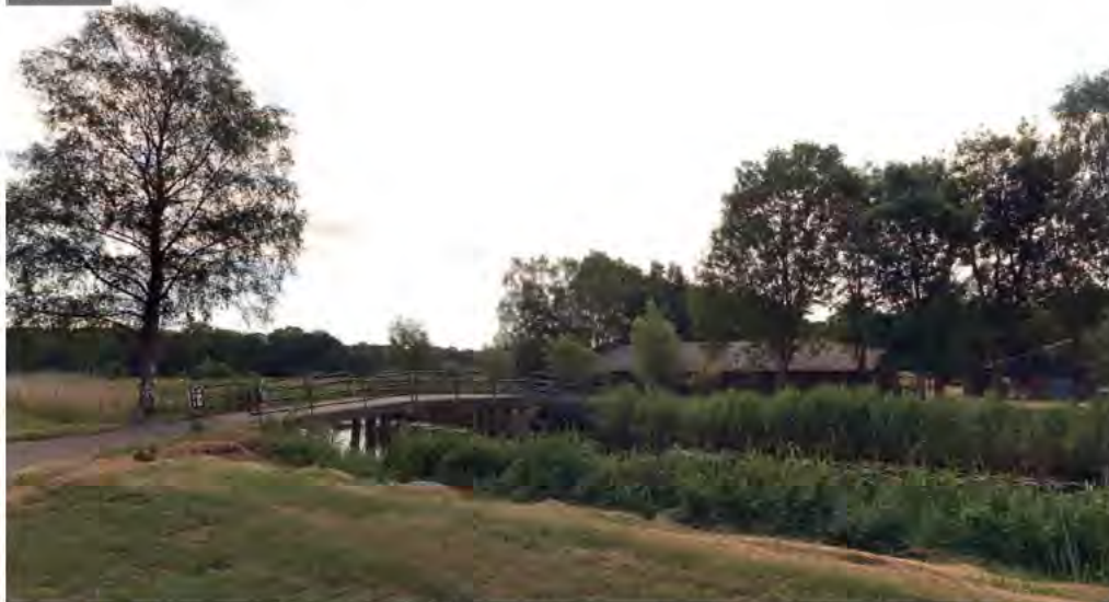
Figuur 4-28: Erftoegangsweg door middel van een brug (overzijde buitenwater betreft Meentkade Zuid).
