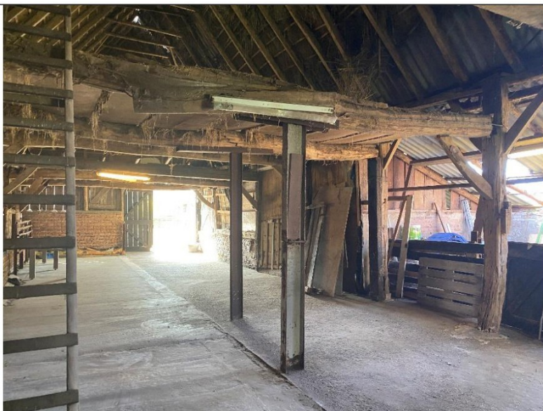
7. Interieur met onderstempelde ankerbalken
