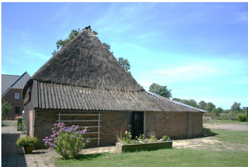
13. Metselwerk aangesleepte aanbouw (NO) rechts wordt gesloopt
