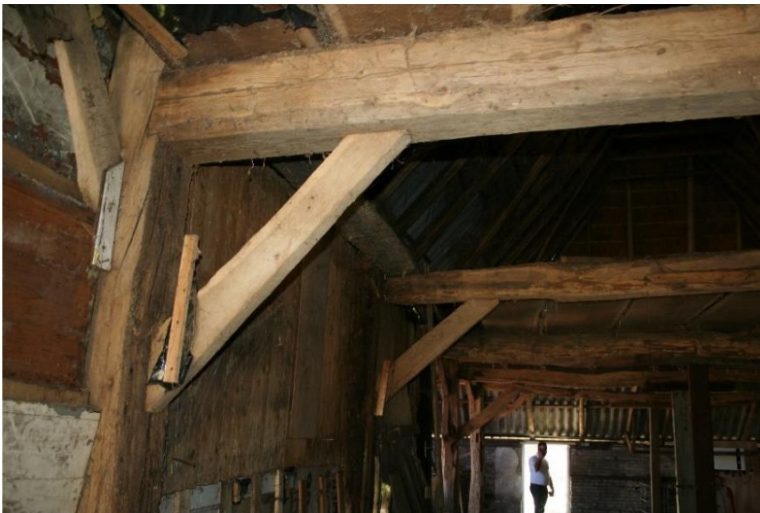
16. Derde gebint: grenen houten ankerbalk
