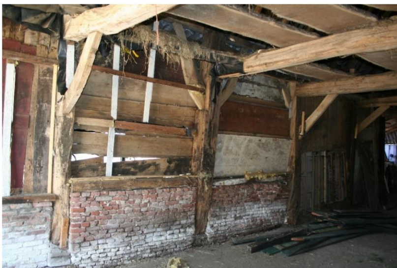
14. Twee vakken met oud metselwerk (andere kant is straks zichtwerk aan noordwestzijde)
