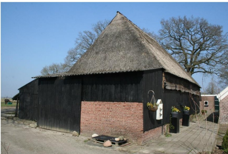
3. Zuidwestgevel met aanbouw onder lessenaarsdak
