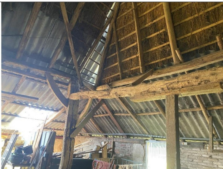
18. Aangesleepte dakje dat behouden blijft: tussen de bestaande sporen een extra spoor aanbrengen
