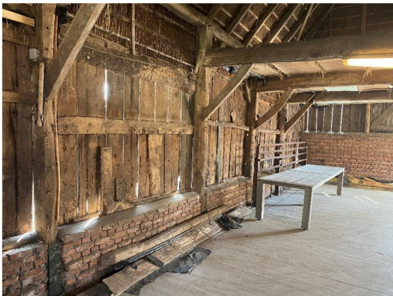
6. Interieur met ankerbalkgebinten
