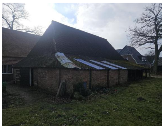
Golfplaten op de achterzijde en uitbouw delen
