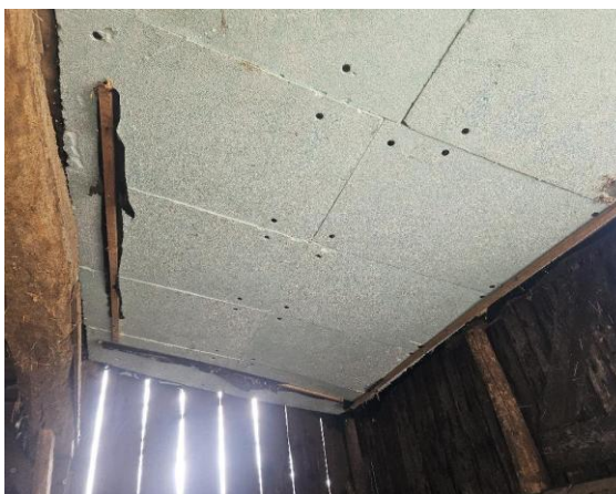
Deel isolatie onder de dakbedekking
