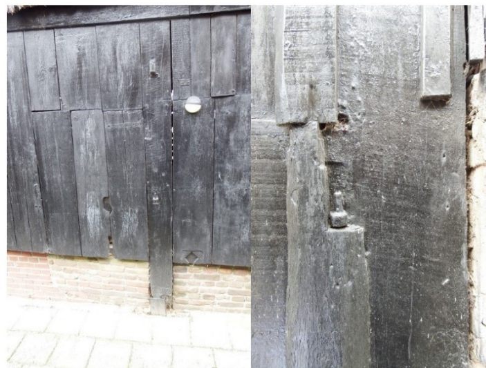
Afb. 46: Details van de vorige foto met de deuropening (links) en de ongebruikte duim in de stijl met merk VII (rechts)
