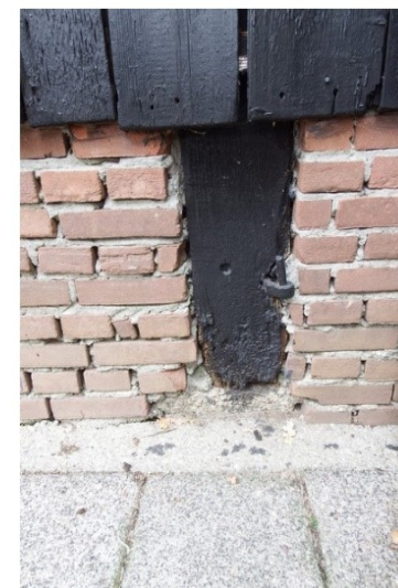
Afb. 44: De vierde gebintstijl vanaf links (achtergevel) met duimen en op verschillende hoogte zichtbare toognagels (links) en een detail van het vernieuwde gevelgedeelte.
