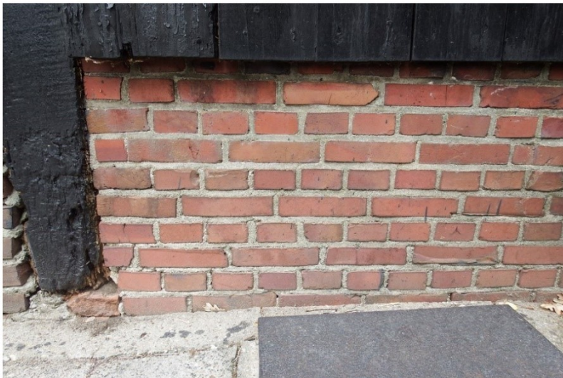
Afb. 25 Vervangen metselwerk in de voetmuur rechts naast de vierde gebintstijl.
