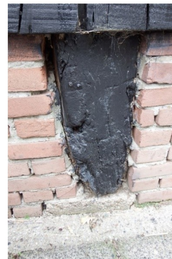
Afb. 30: Detail metselwerk in de voetmuur. Links de achtergevel en rechts de linker zijgevel met een gebintstijl op een betonnen poer.
