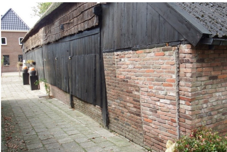
Afb. 43: Zijgevel gezien vanaf de voorzijde met de slagschaduw van de boerderij. Op de aansluiting van de voor en zijgevel is een gemetselde kolom zichtbaar.
