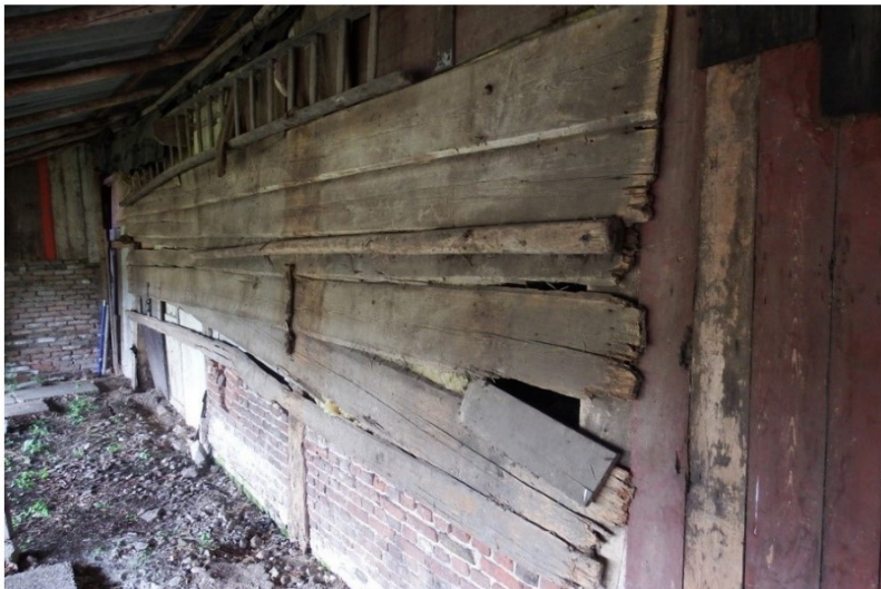
Afb. 39: Onder het afdak aanwezige achterste gedeelte van de rechter zijgevel.
