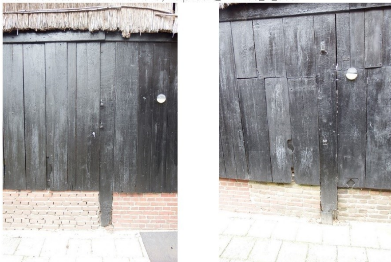
Afb. 3: Verticale beplanking in de naar de weg gekeerde gevel met deuropeningen. Links de rechter stijl van de centrale opening en rechts een van de deuren rechts daarvan.
