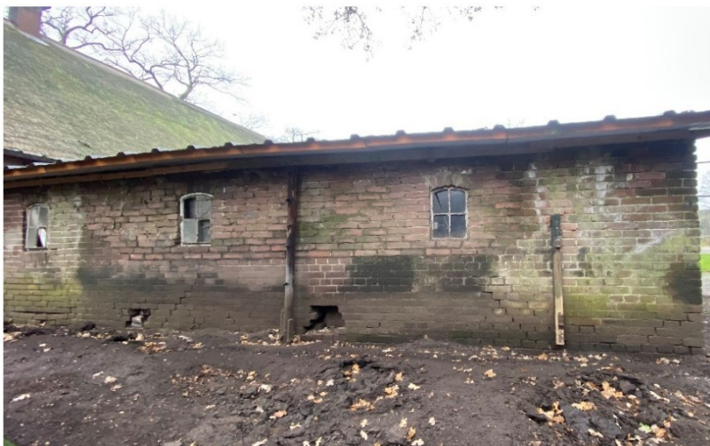
Afb. 49: Het rechtergedeelte van de voorgevel met een houten venster en drie gietijzeren ramen.
