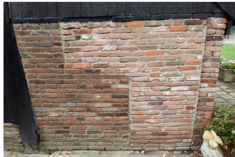
Afb. 28: De versteende zijgevel met een staldeur en een zijlicht.
