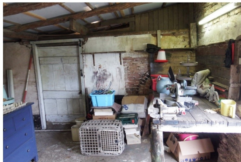
Afb. 56: De rechter zijwand van het varkenshuis met de niet gepleisterde afdruk van het gesloopte ovenlichaam.
