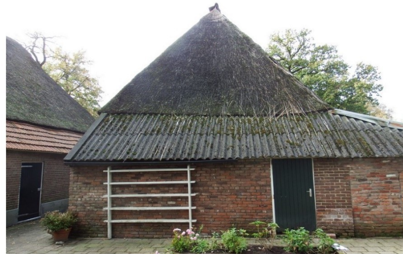
Afb. 38: Voorgevel van de schuur met de verschillende metselwerk vlakken.
