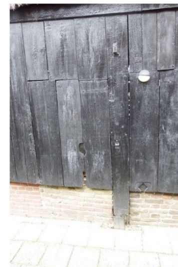
Afb. 19: Verticale beplanking in de linker zijgevel met voormalige deuropeningen. Links de rechter stijl van de centrale opening en rechts een van de deuren rechts daarvan.
