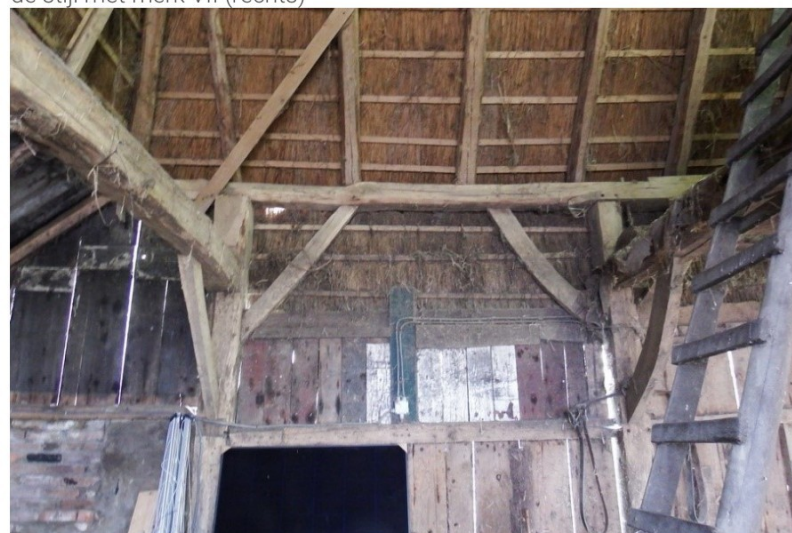
Afb. 48: Gebintconstructie gezien naar de linker zijwand.
