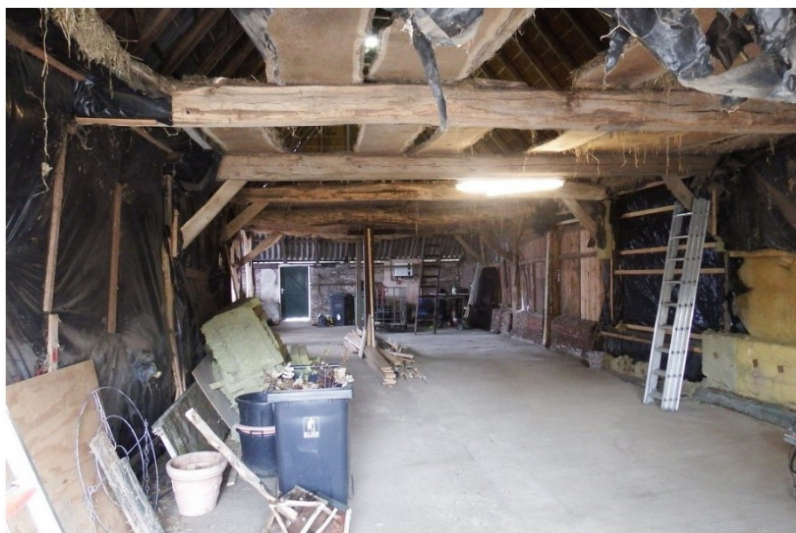
Afb. 47: Interieur van de schuur vanaf de achterzijde met de van landbouwplastic voorziene wanden, waarachter isolatie is aangebracht.
