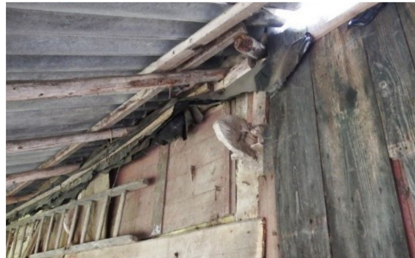
Afb. 26: Afgezaagde hoekkeperbalk tegen de gebintstijl in de zijbeuk.
