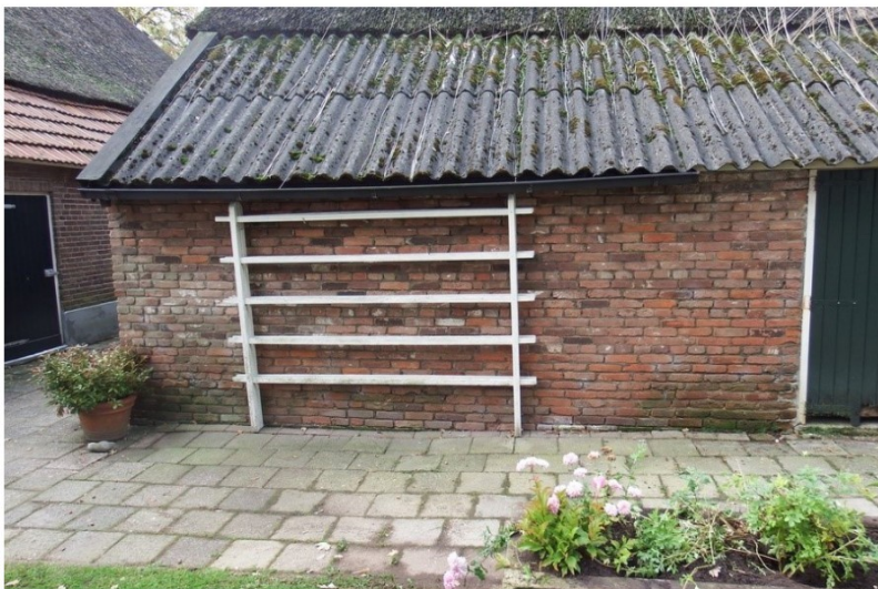
Afb. 27: Vernieuwde voorgevelmetselwerk, aansluitend op een gemetselde hoekkolom.
