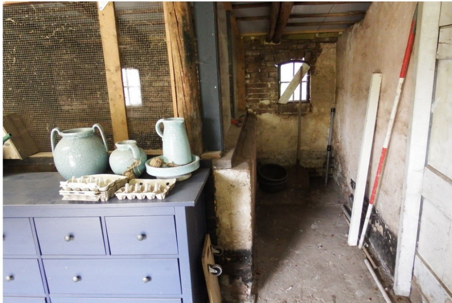
Afb. 57: Linker zijwand van het varkenshuis met op enige afstand de steens dik gemetselde stalafscheiding.
