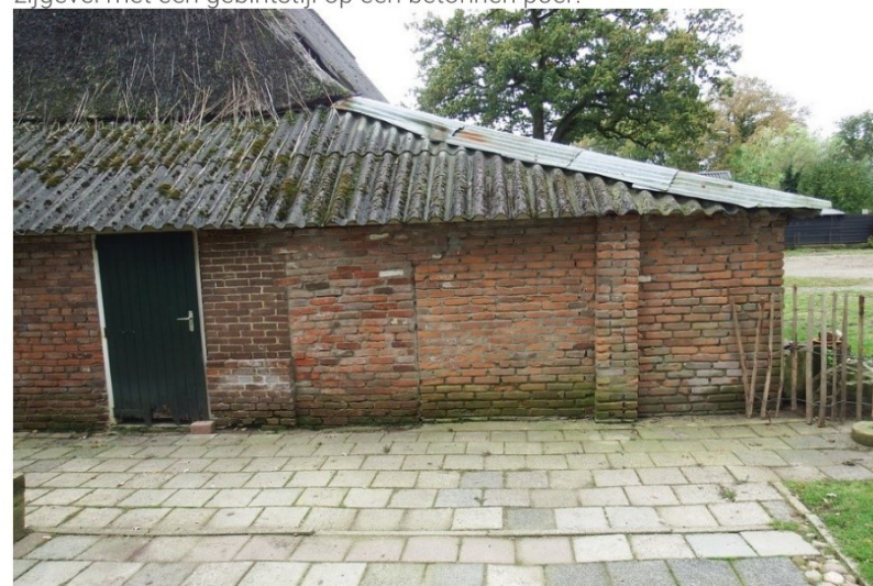
Afb. 32: De verbrede voorgevel van de schuur met penant, waarin een dichtgezette deuropening.
