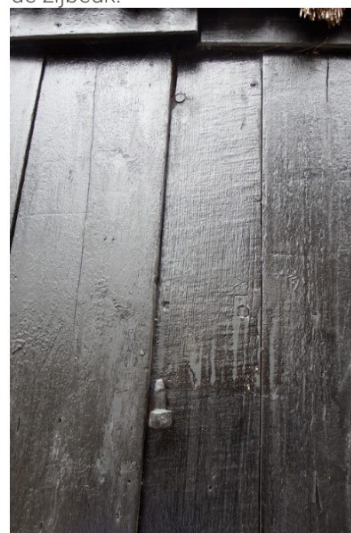
Afb. 44: De vierde gebintstijl vanaf links (achtergevel) met duimen en op verschillende hoogte zichtbare toognagels (links) en een detail van het vernieuwde gevelgedeelte.
