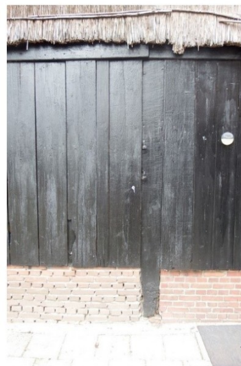
Afb. 19: Verticale beplanking in de linker zijgevel met voormalige deuropeningen. Links de rechter stijl van de centrale opening en rechts een van de deuren rechts daarvan.
