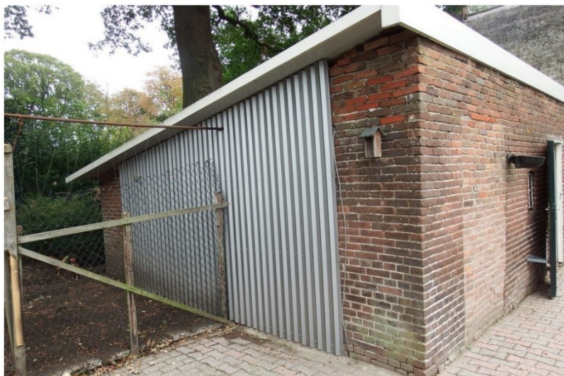
Afb. 35: Rechter zijgevel op de achtergevel met de stalen gevelbekleding. Op de hoek met de achtergevel is de verhoging van het metselwerk zichtbaar.
