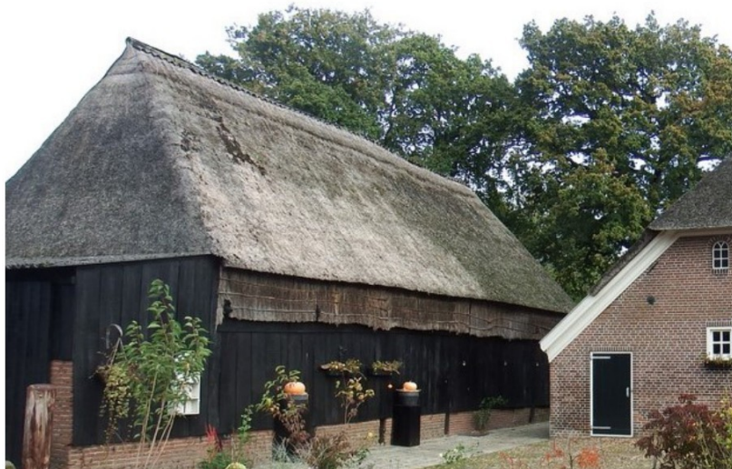
Afb. 29: Geheel links de vergroting van de schuur onder het flauwhellende lessenaarsdak. De voetmuren van de voor- en rechter zijgevel zijn gemetseld zonder voegwerk.
