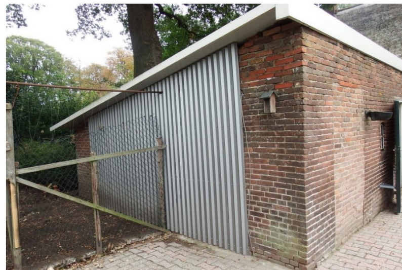
Afb. 50: Rechter zijgevel op de achtergevel met de stalen gevelbekleding. Op de hoek met de achtergevel is de verhoging van het metselwerk zichtbaar
