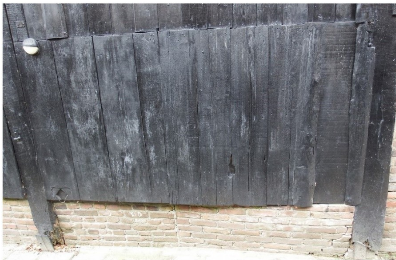
Afb. 45: Rechter gedeelte van de gevel met de dichtgezette deuropening in de beplanking.
