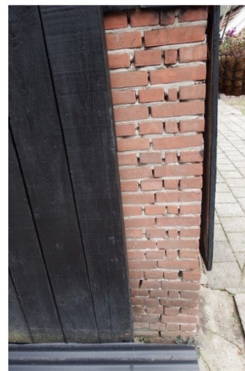
Afb. 30: Detail metselwerk in de voetmuur. Links de achtergevel en rechts de linker zijgevel met een gebintstijl op een betonnen poer.
