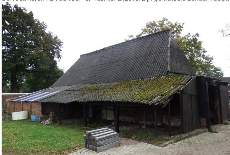
Afb. 31: Verbreiding zijbeuk tegen de rechter zijgevel. Aan de achterzijde is het beplankte gevelgedeelte met de oorspronkelijke breedte gehandhaafd.
