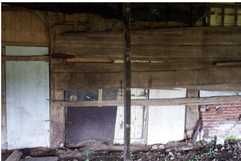
Afb. 41: Detail van de gevel met de ontbrekende voetsmuur en doorlopende beplanking
