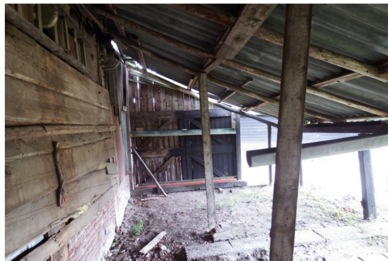
Afb. 42: Rechter zijgevel met op de achtergrond de binnenzijde van de achtergevel van de zijbeuk.
