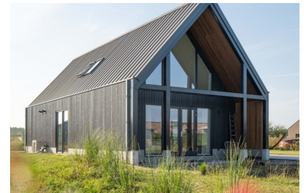
Hoofdgebouw met deels open kap voor de voorzieningen (Bron: Woonmagazine).
