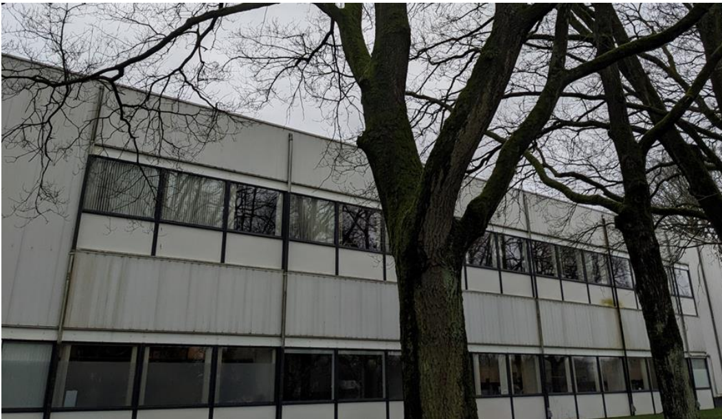
Figuur 3.5 Gebouw potentieel geschikt als onderdak voor gebouw bewonende vleermuizen.
