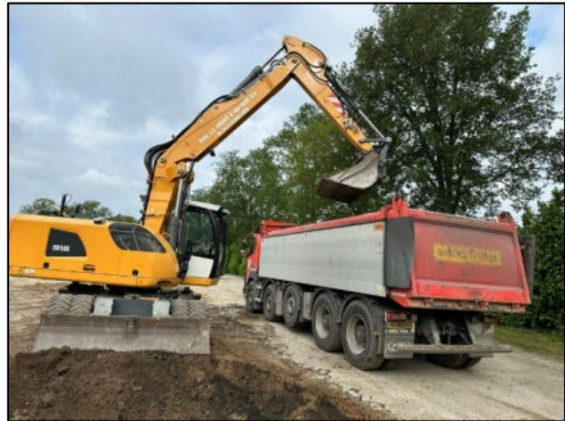
Foto 2: ontgraven en afvoeren verontreinigde grond
