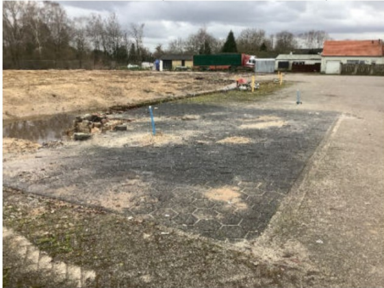
Foto: deellocatie A (vloeistofdichte vloer)
