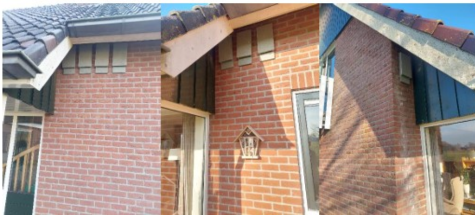
Figuur 8: Alternatieve vleermuiskasten geplaatst op 13 januari 2026 aan de oost-, west- en zuidgevel van het woonhuis.
