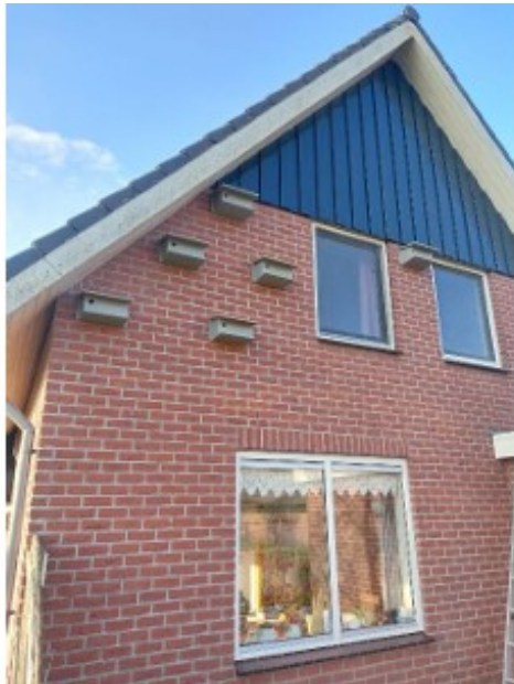
Figuur 7: Alternatieve huismuskasten op 13 januari 2026 geplaatst aan de noord-oostgevel van het woonhuis.
