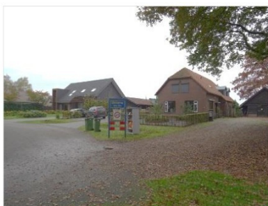
Figuur 2.3 Woningen gezien vanuit het noordwesten.
