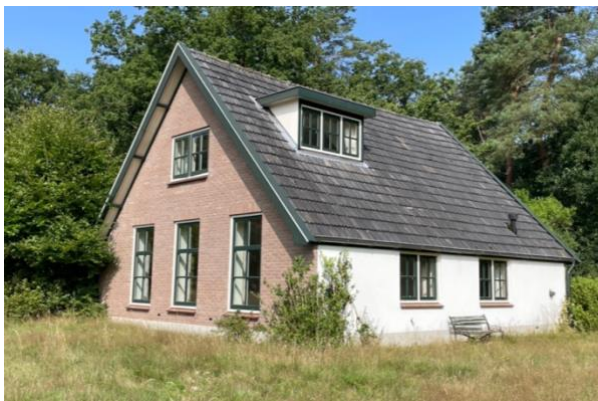
Figuur 3: Achterzijde woonboerderij, zuidoostzijde.
