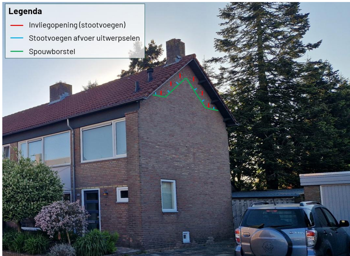
Figuur 4. Permanente alternatieve voorziening voor de laatvlieger in de nok. De invliegopeningen zijn in rood weergegeven. De stootvoegen voor afvoer van uitwerpselen bij de onderzijde van de voorziening zijn in blauw weergegeven. Op de plek van de groene lijn wordt een spouwborstel gemonteerd zodat de spouwisolatie niet terug naar boven kan. Let op, dit is een verouderde weergave; In de voorschriften van dit besluit is opgenomen dat er slechts 2 stootvoegen open zullen zijn om in te vliegen en enkel de onderste stootvoegen open zijn voor de afvoer van uitwerpselen.
