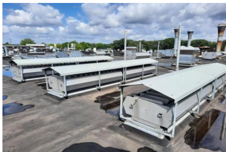
Foto 1: open dak constructie doorloopovens
