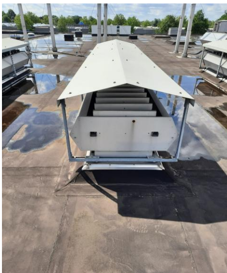
Foto 2: open dak constructie doorloopovens, Situatie precies boven 1 oven
