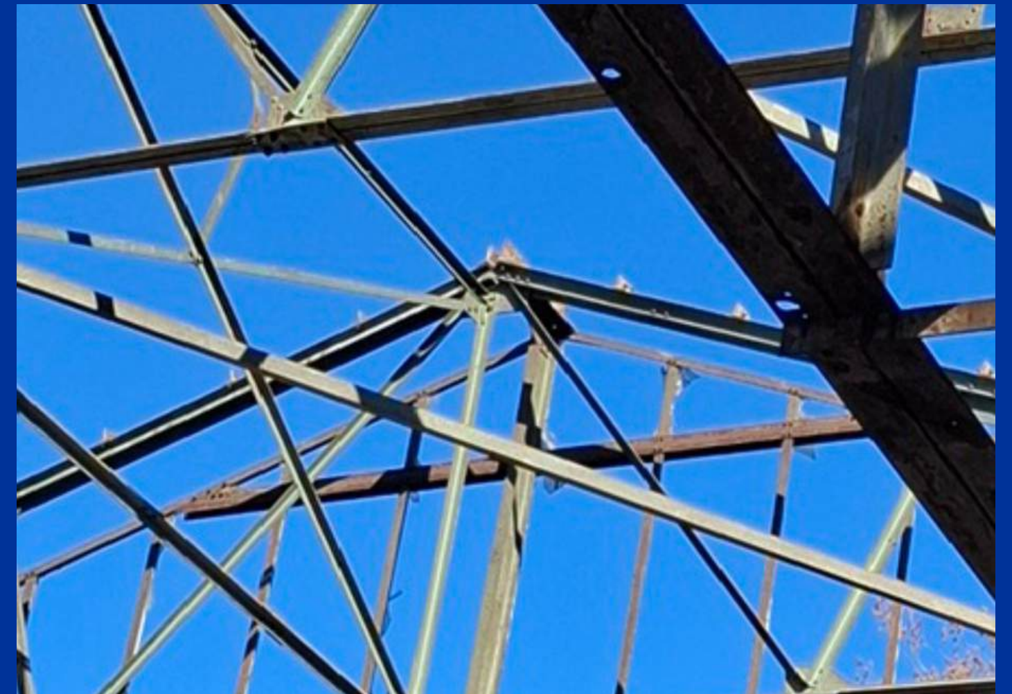
De bestaande situatie bij de noordgevel.
