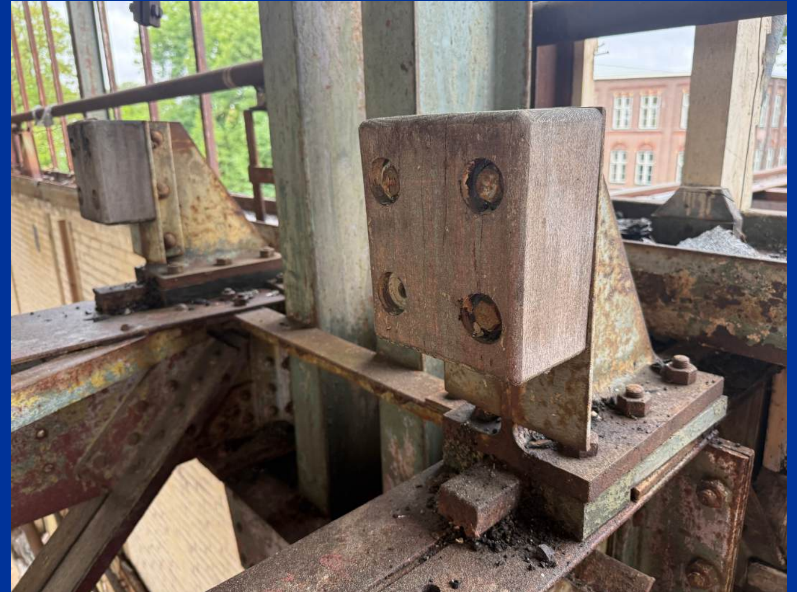
Stalen stopelement met houten kop op de doorlopende kraanbaan. De achterste hoort bij de kraanbaan van de andere hal die niet doorloopt.
