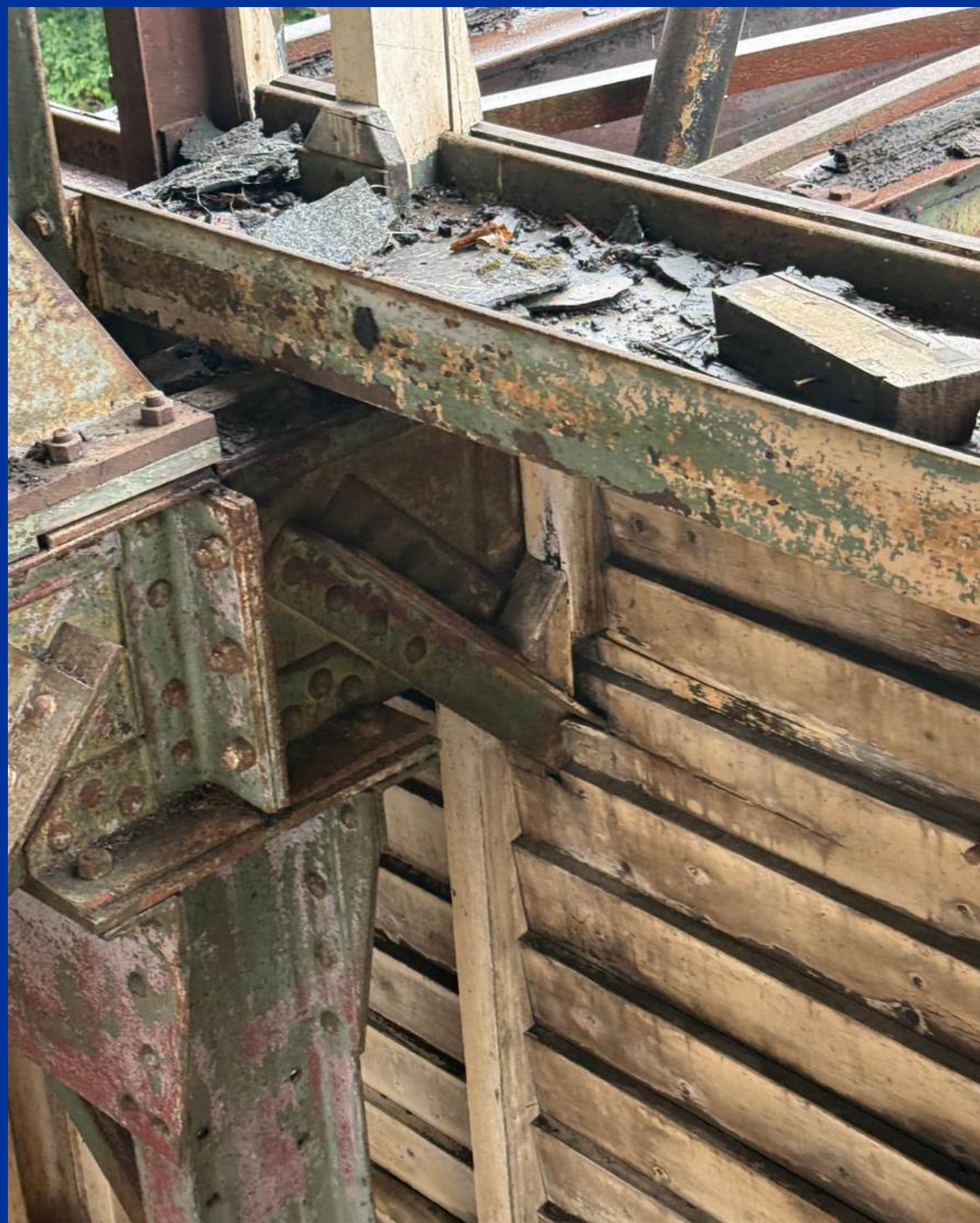
De stalen u balk die op de doorlopende kraanbaan ligt
