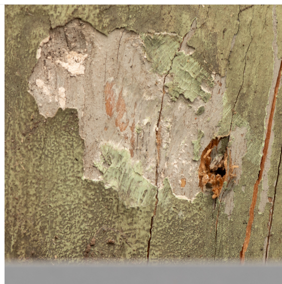
Binnenzijde houten deur
