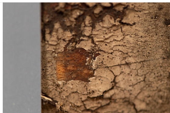
Onderzijde dakbeschot binnenzijde
