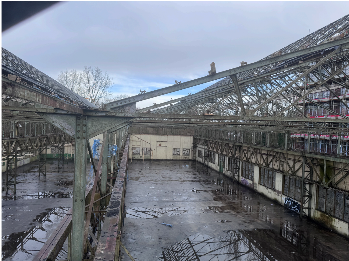
Interieur gebouw 320 na ontmanteling dak, dd. 2026
