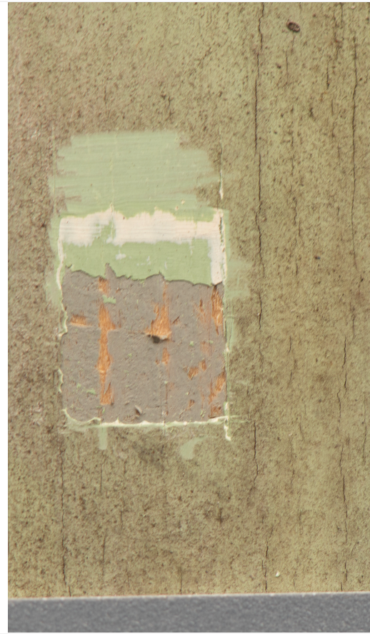
Binnenzijde houten deur
