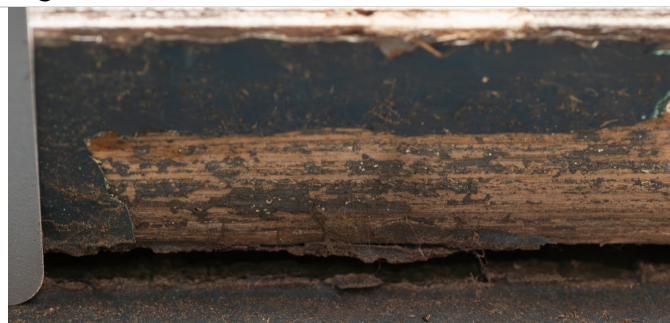
Stratigrafie onderzijde houten geveldelen
