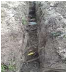
Foto 11 proefsleuf met kabels en leidingen
