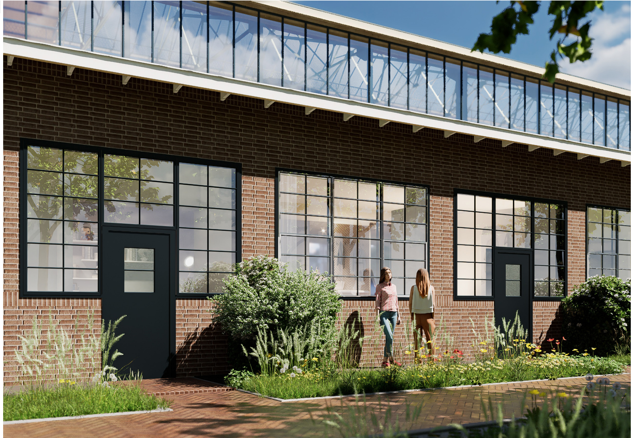
Zicht op de westgevel
