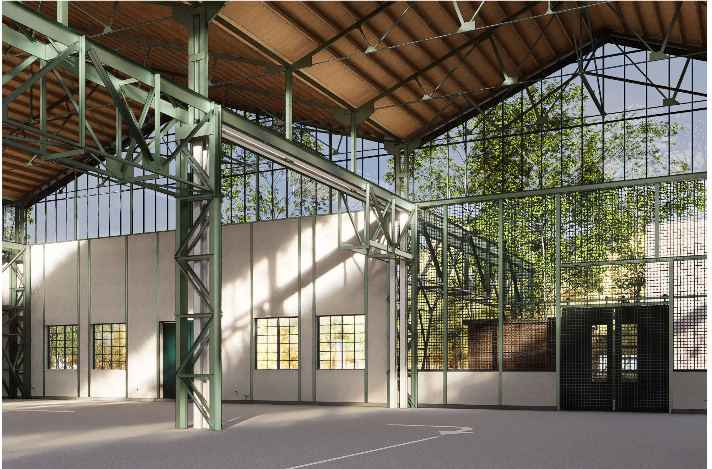
Portaalspant tussen bestaande constructie
