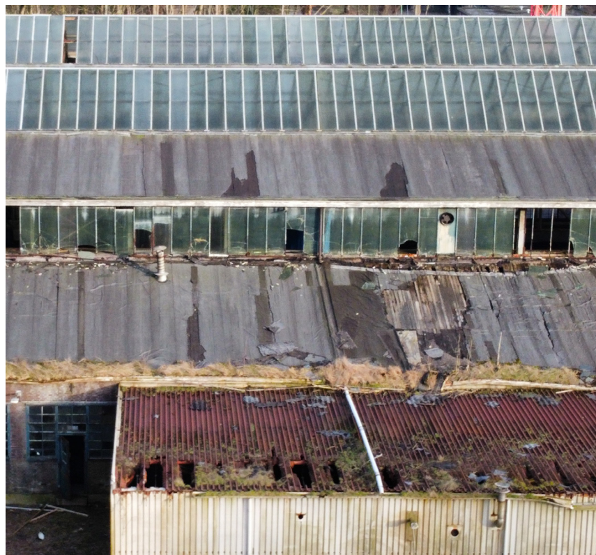
niet-monumentale aanbouw (wit) wordt gesloopt
