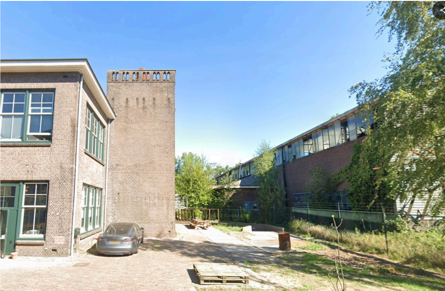
westzijde bestaande situatie (vanaf zuiden)
