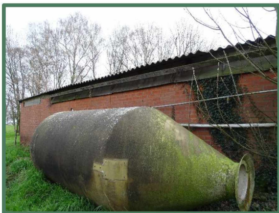
Foto 24: Open voersilo langs noordwestgevel.
