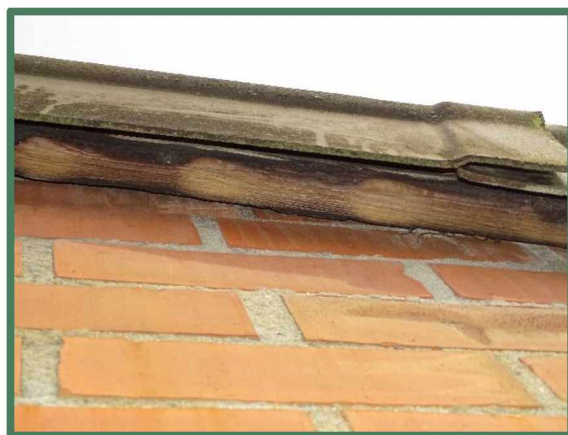
Foto 18: Windveer sluit aan op gevelmuur middels houten lat.
