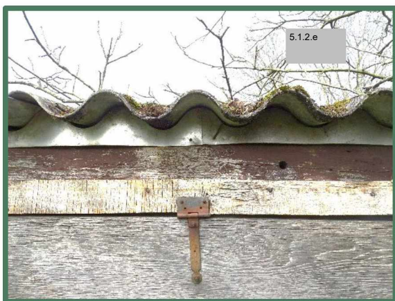
Foto 19: Ruimte onder golfplaten afgedicht met profielvulling.
