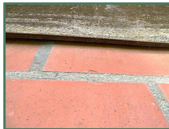
Foto 20: Houtwerk sluit strak aan op gevelmuur.
