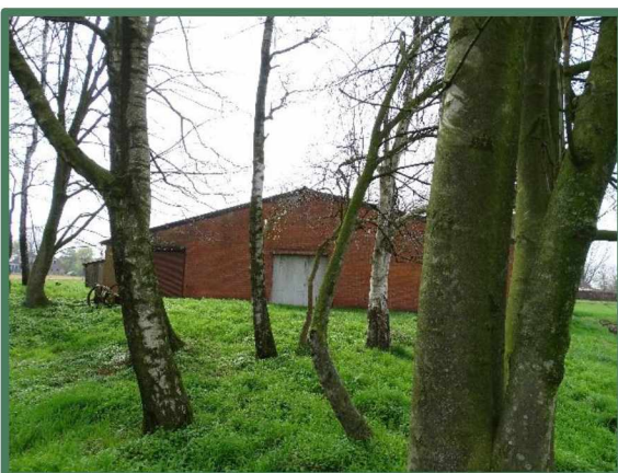
Foto 8: Achtergevel stal vanaf noordoostelijke houtopstand.
