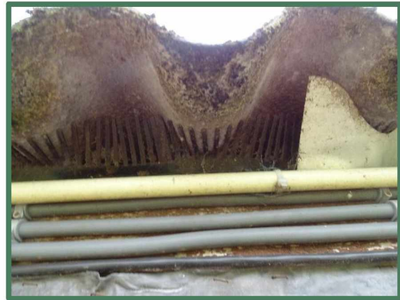
Foto 29: Profielvulling gaat over in vogelschroot.
