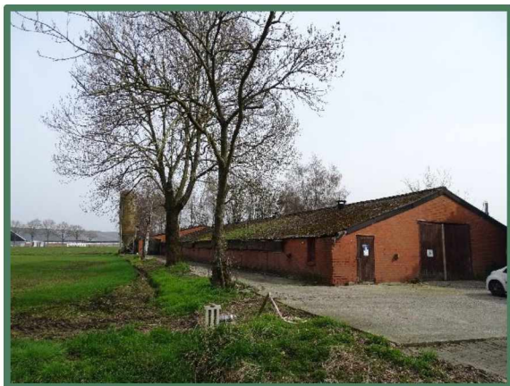
Foto 1: Vleeskuikenstal vanaf Klein Bedaf.
