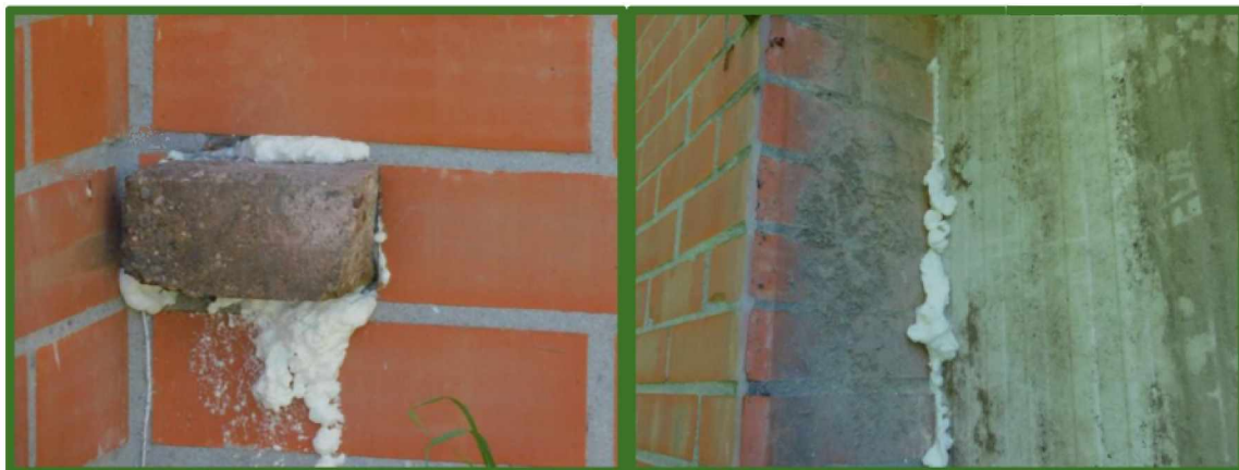
Gaten en kieren volledig dicht gemaakt met isolatieschuim
