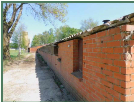
Westelijke zijde vleeskuikenstal
