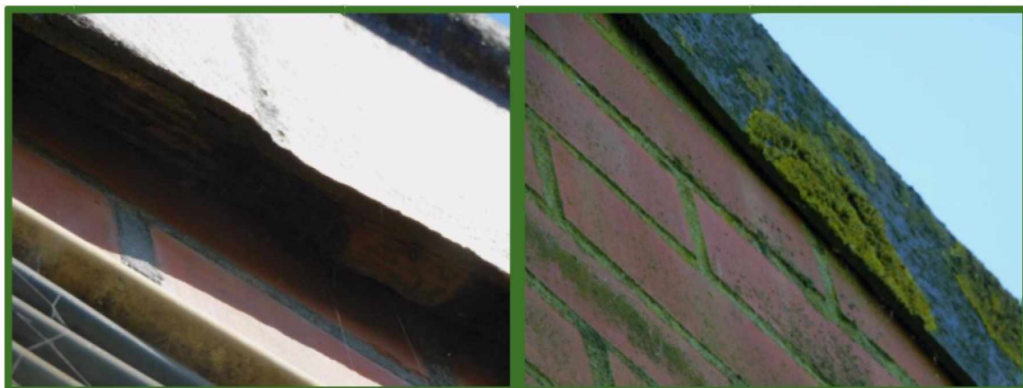
Windveer dichtgemaakt met panlat ertussen
