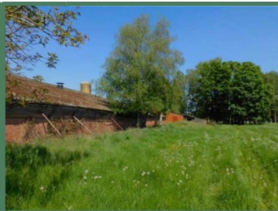
Oostelijke zijde vleeskuikenstal
