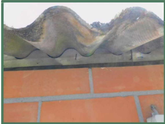
Ruimte tussen dak en muur volledig gesloten
