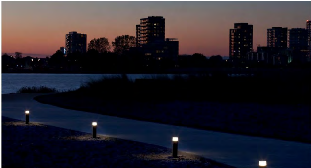
Bolderverlichting (solar Led-Verlichting)
