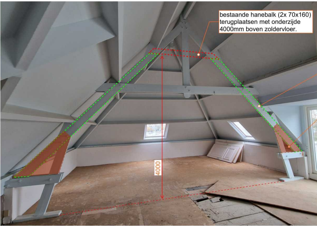
Bestaand spant met aanpassing hanebalk
