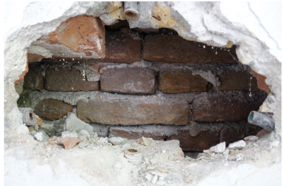
Blik door een opening in de binnenmuur op de spouw en de buitenmuur, in een vertrek op de eerste verdieping van de villa.
