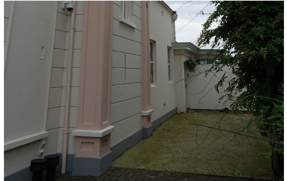
Het dak van de aanbouw tegen de westgevel vormt de bestrating in de 'zijtuin'.
