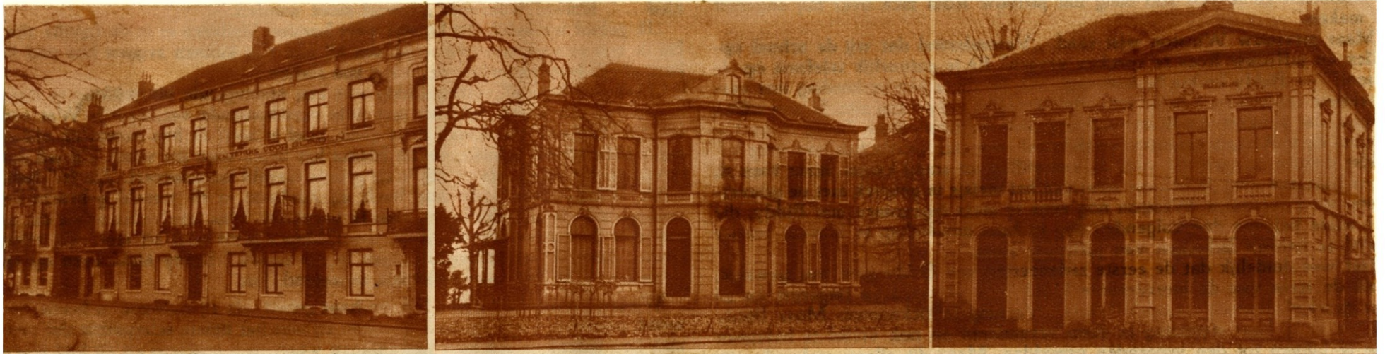
De gebouwen van de Geldersche Blinden Vereeniging in 1932. Van links naar rechts: Marktstraat, Utrechtseweg 67 (Villa Reale) en Utrechtseweg 69 (Villa Clara). Aan het middelste pand valt op dat alle vensters in de voorgevel, behalve die in de driezijdige uitbouw, nog zijn voorzien van persiennes.
