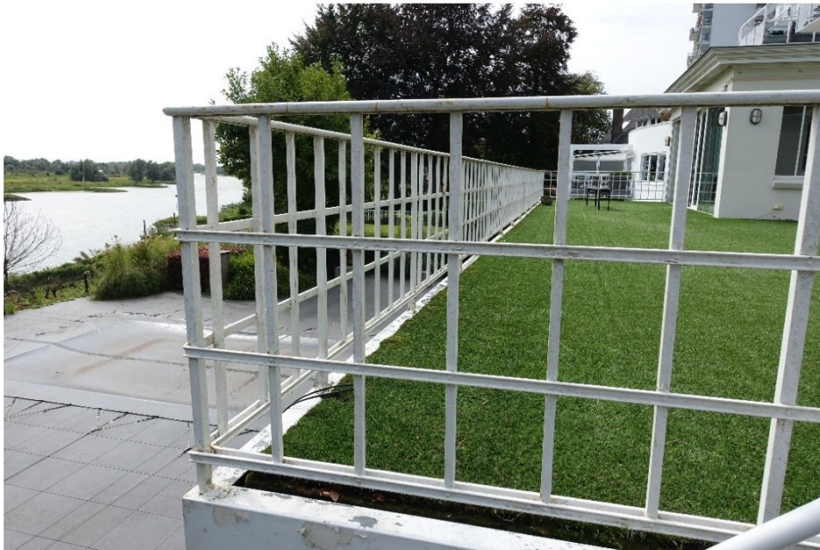
Het balkonhek is nog origineel, maar op zijn minst gedeeltelijk verplaatst.
