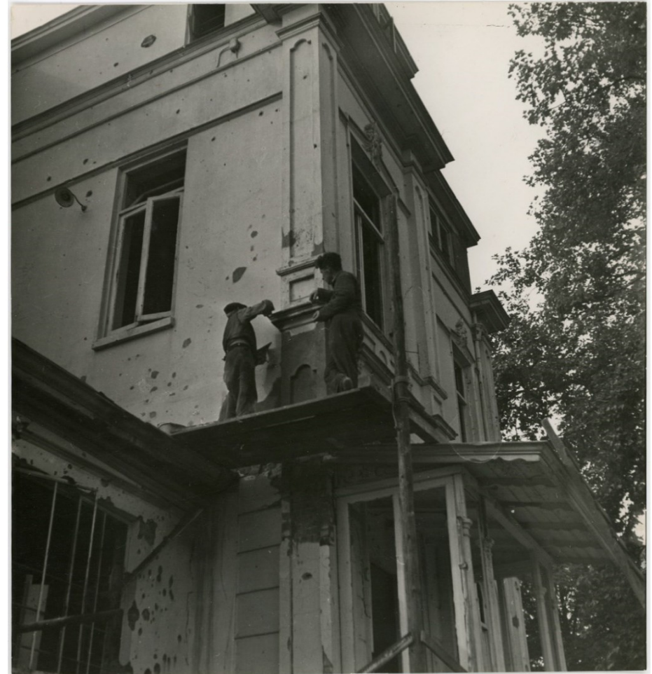
Herstelwerk aan de achtergevel en de linkerzijgevel in september 1945. Bron: E.E. Andriesse, beeldbank GA, 4291-24.
