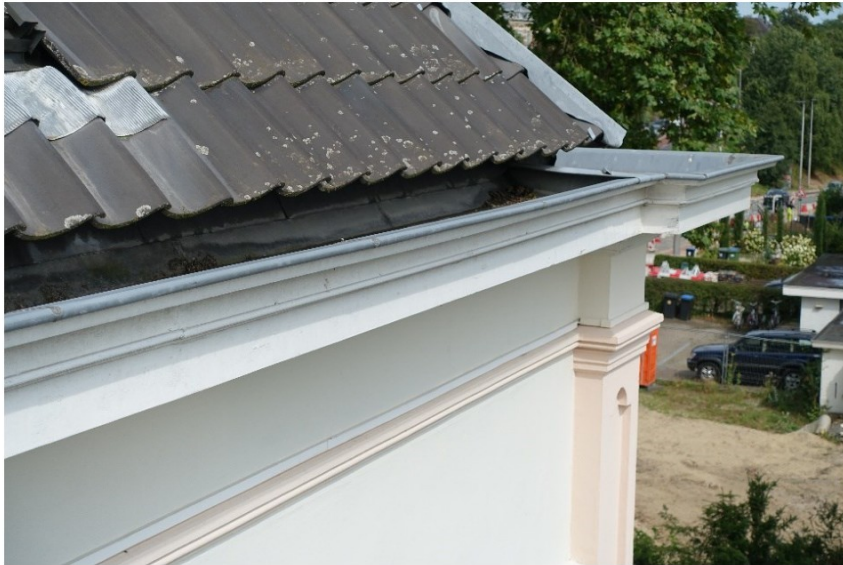
De daklijst en de met oude holle pannen belegde kap van de villa.
