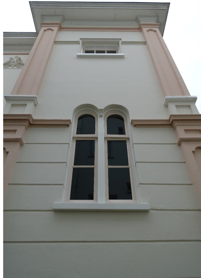
De vensters van het trappenhuis.
