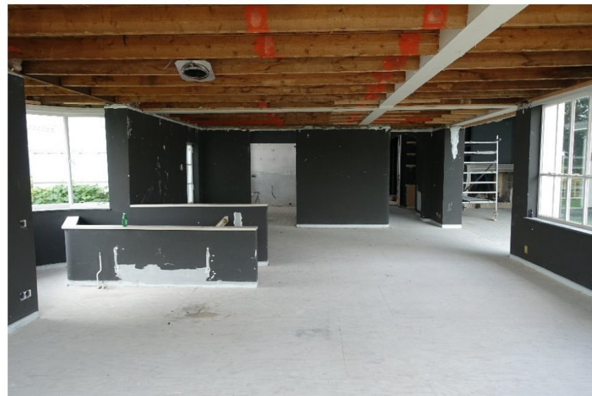
Een verdieping hoger is de balklaag met stalen liggers zichtbaar.
