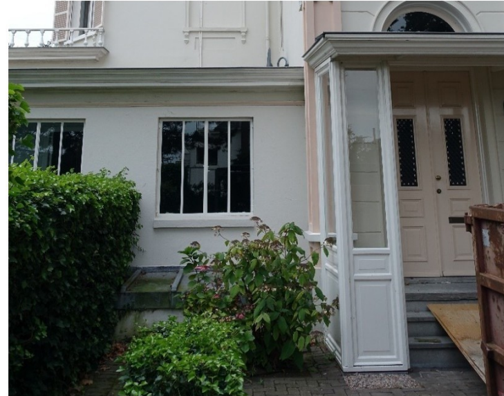
Het rechter deel van de linker zijgevel. Onder het venster springt een ondergrondse uitbouw naar voren.
