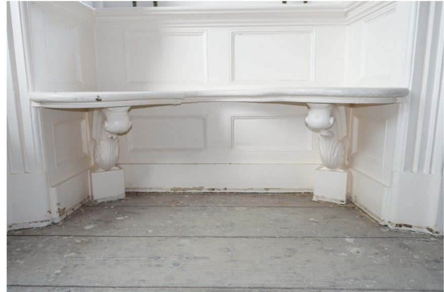
Eén van de vensterbanken met consoles in vertrek 0.3.
