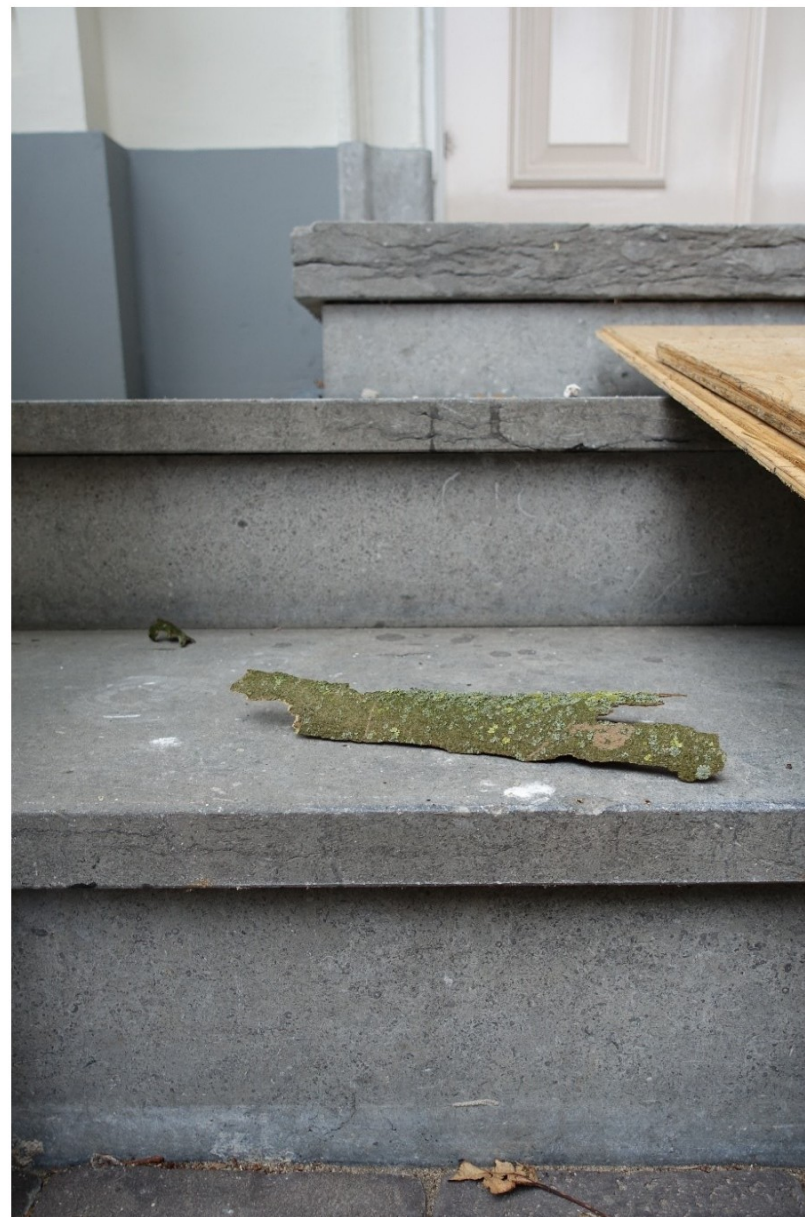
De hardstenen trappen vóór de ingang. Alleen de dikke bovenste trede is mogelijk nog authentiek, de andere zijn waarschijnlijk in de jaren 1990 vernieuwd.
