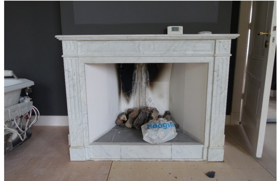
De schoorsteenmantel met gecanneleerde pilasters in vertrek 1.4.
