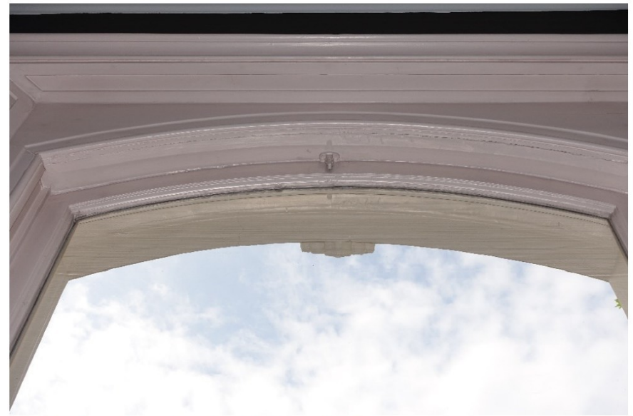
Een detail: een kleine katrol midden boven het linker venster.
