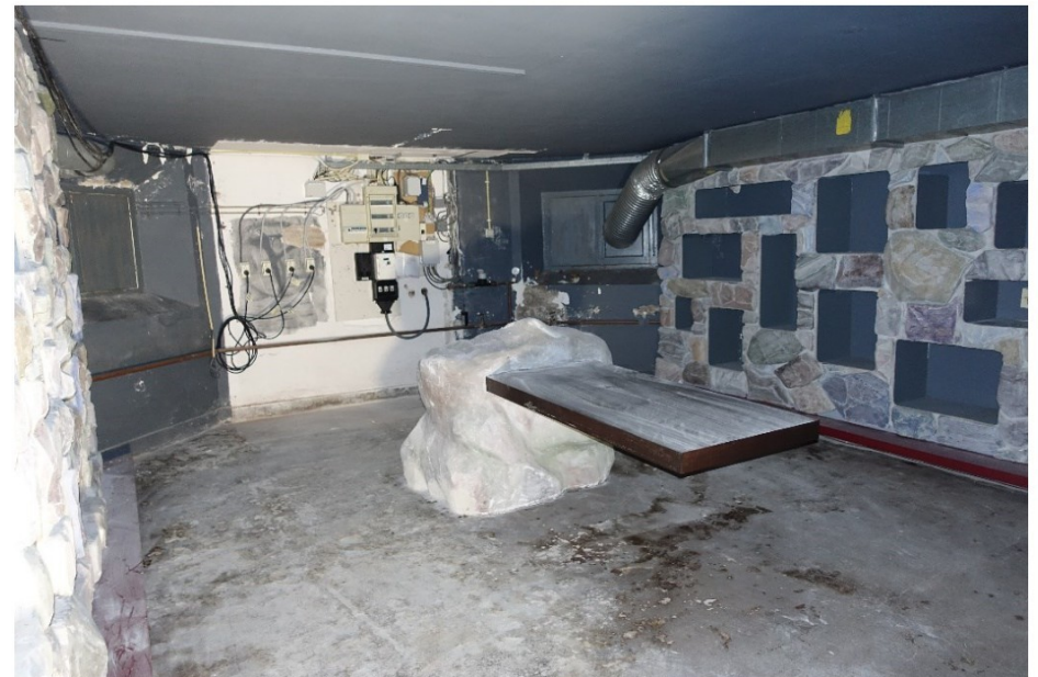
De wijnkelder (vertrek -1.4), met achteraan twee vensteropeningen met dichtgezette kelderkoekoeken.
