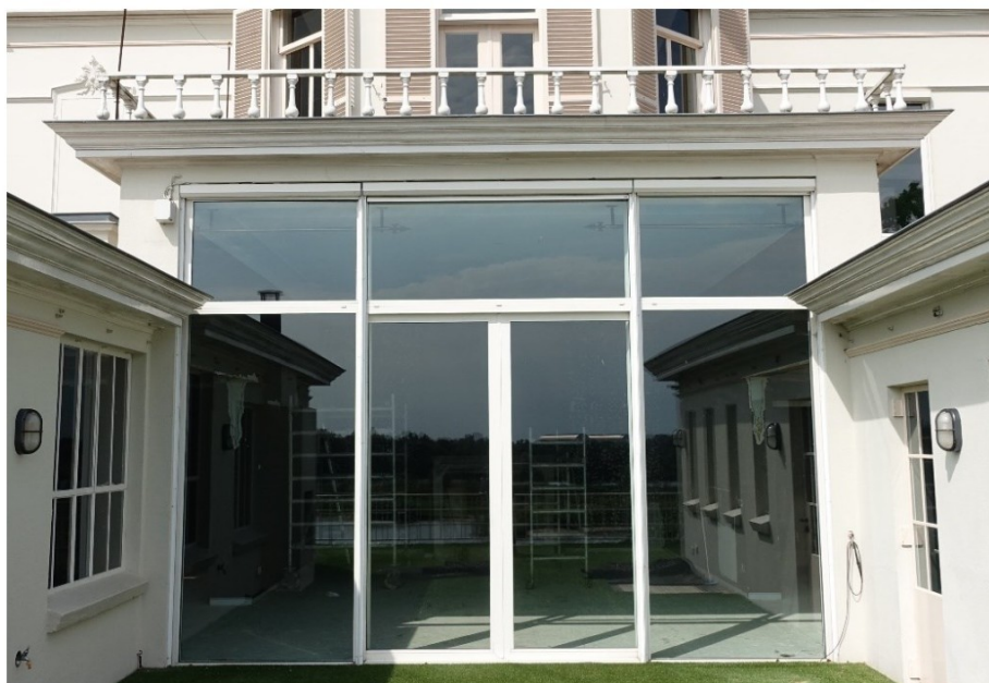
De pui van het verbindende middendeel. Bovenop de afwijkend vormgegeven balustrade van het dakterras.
