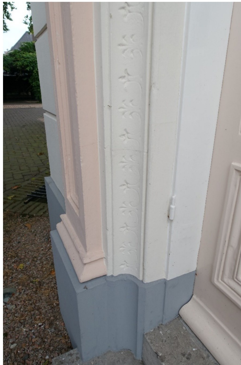
De omlijsting van de centrale deur in de driezijdige uitbouw is wat rijker uitgevoerd dan die van de andere deuren: met motieven van lelies en (lichtroze beschilderde) lisenen.
