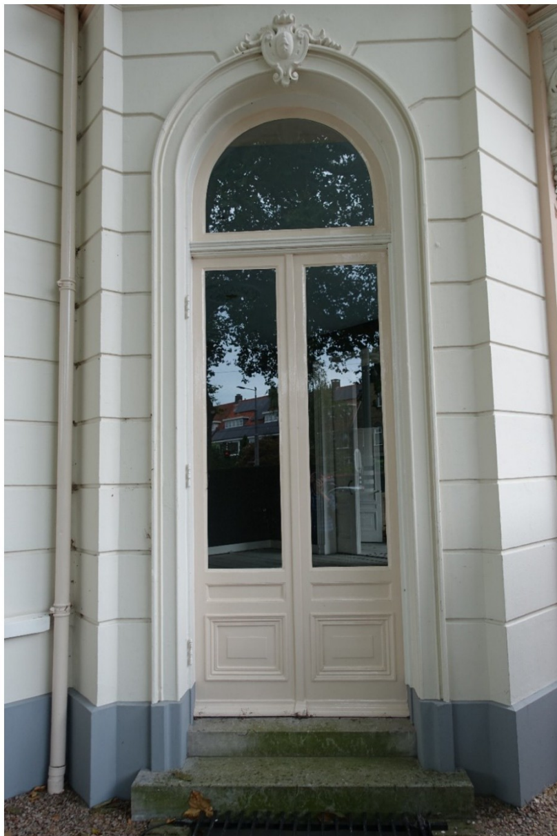
Deuropening met hardstenen treden in de driezijdige uitbouw. Scharnieren links wijzen op de vroegere aanwezigheid van persiënnes.
