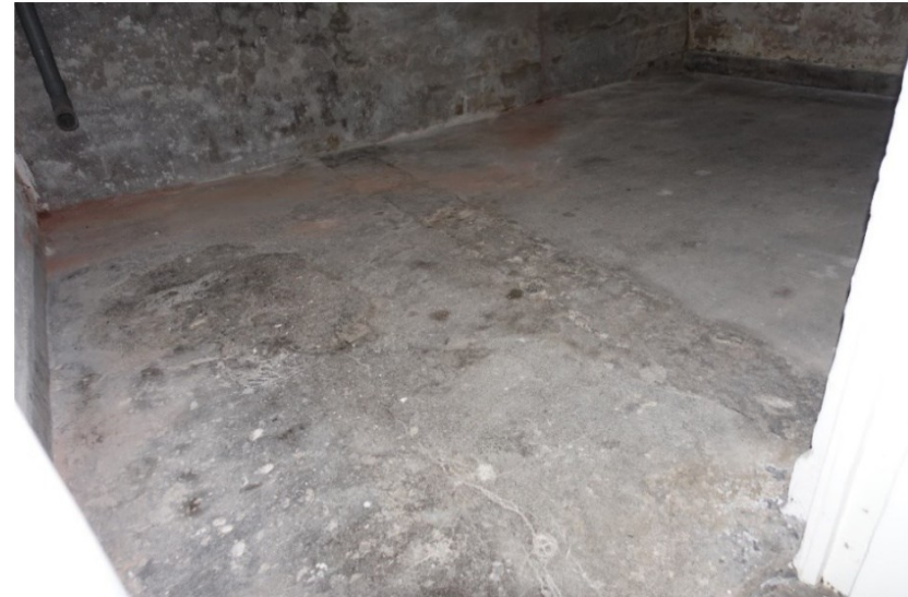
De vloer van vertrek -1.5b, gezien in noordwestelijke richting. De verdwenen tussenmuur scheidde in 1873 de brandstofbergplaats (links) van de knechtskamer, die ook vertrek -1.5a omvatte.
