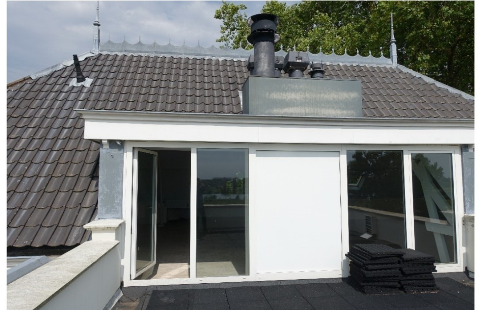
De aanbouw in de kap, aansluitend op het balkon.
