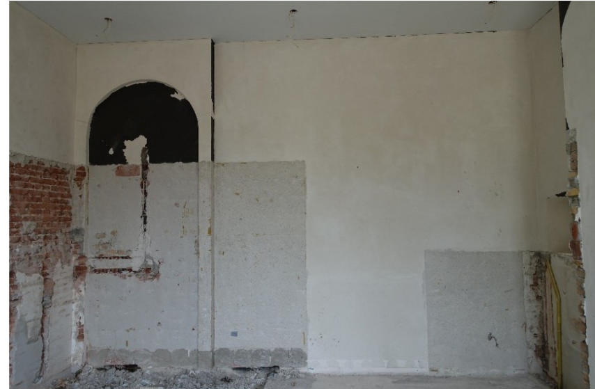
De zuidzijde van vertrek 1.5. Links onder de rondboog was oorspronkelijk de doorgang naar het trappenhuis (vertrek 1.2c).
