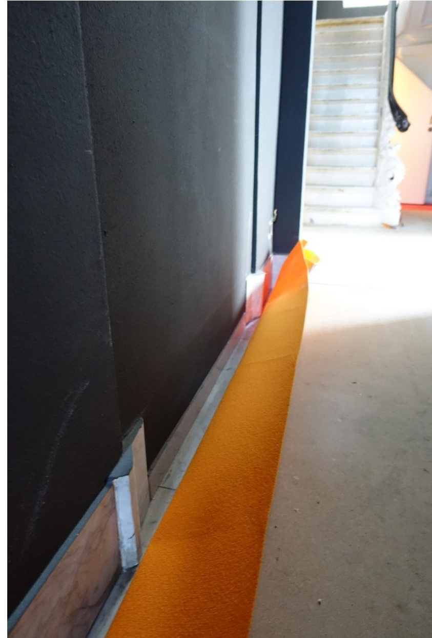
Eén van de dichtgezette deuropeningen in de zuidelijke zijmuur van de gang.
