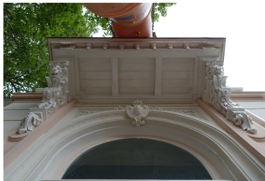
De onderzijde van het centraal geplaatste balkon.
