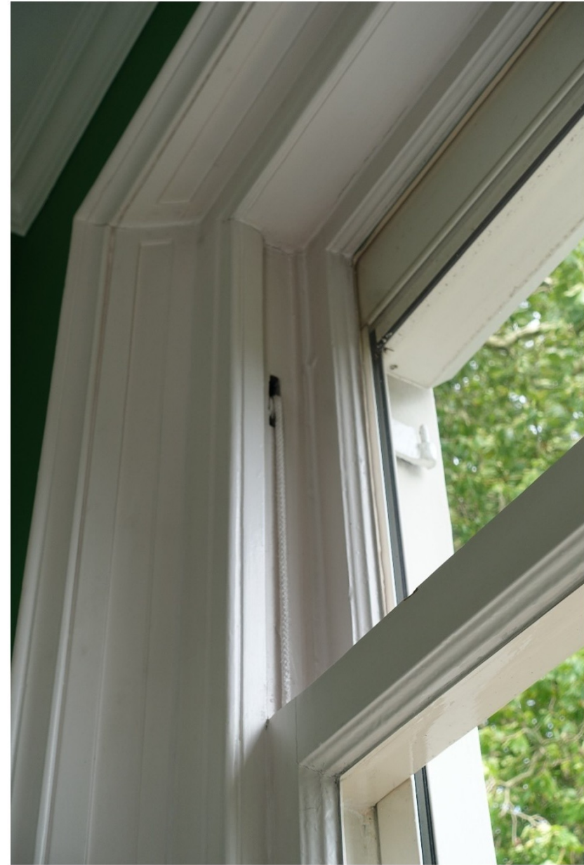
Detail van het schuifraam met betimmering. Aan de buitenzijde is een roluijk aangebracht.
