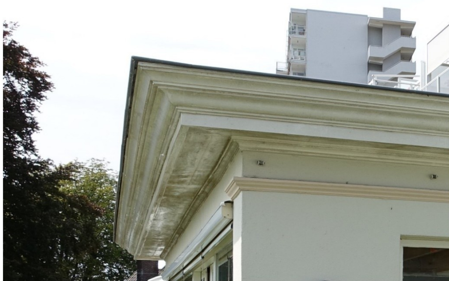
Kenmerkende ver overstekende, geprofileerde dakrand van de aanbouw uit 1938.
