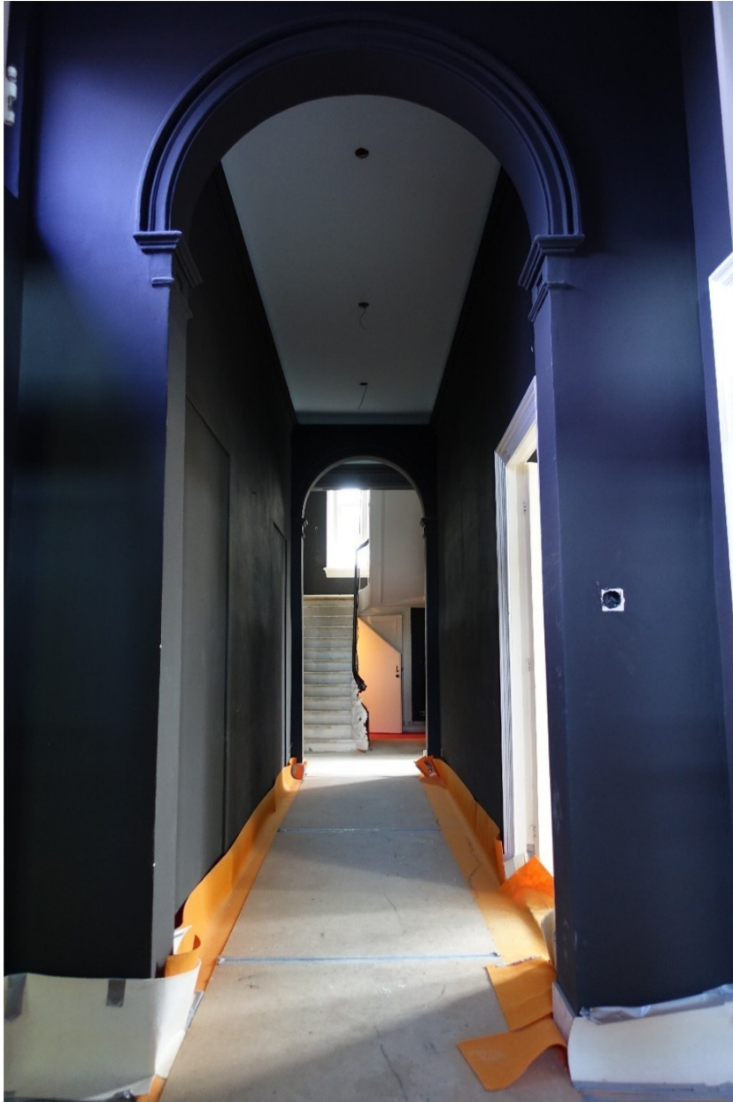
De hal, met op de achtergrond het trappenhuis. Bovenaan een rondboog met omlijsting.
