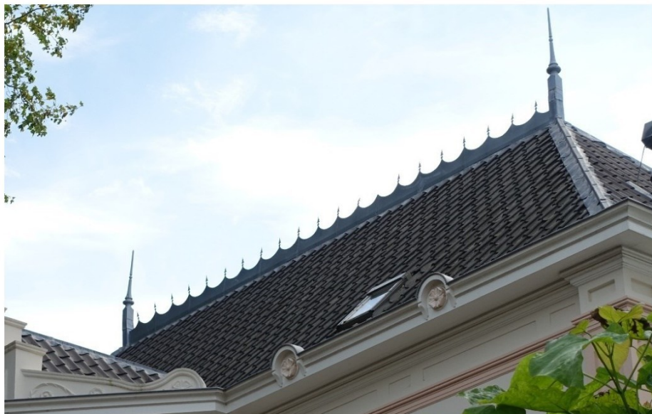
De bekroning van het schilddak met een kam en pironnen.
