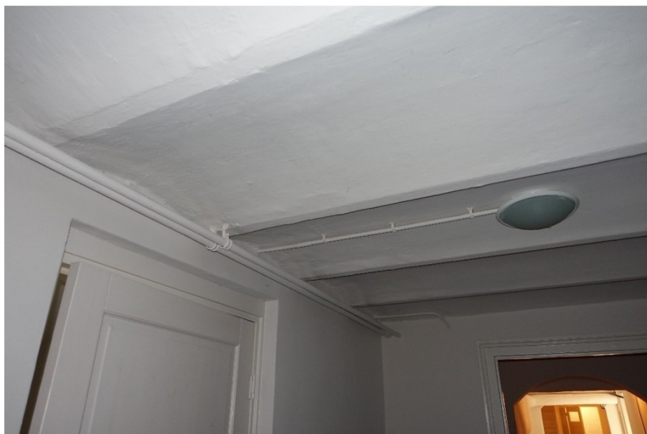
Troggewelven in de kelder van de villa. In diverse vertrekken zijn de gewelven later uit het zicht verdwenen door het aanbrengen van verlaagde plafonds.
