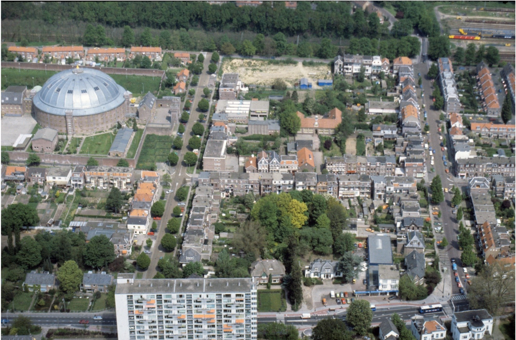
Luchtfoto van de wijk Lombok, gezien in noordelijke richting omstreeks 1980. Linksboven de koepelgevangenis, onderaan de Utrechtseweg en rechts de Oranjestraat. Uiterst rechtsonder staat Villa Reale. De aanbouw links aan de achterzijde heeft nog een eerste verdieping. Bron: beeldbank GA, 1524-12889.
