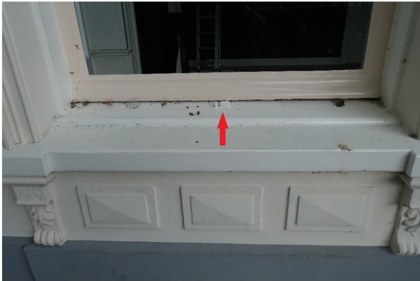
Alle vensters op de begane grond bezitten een rechtopstaande metalen pin midden op de onderdorpel. Waarschijnlijk diende die voor het vastzetten van luiken of andere zonwering.
