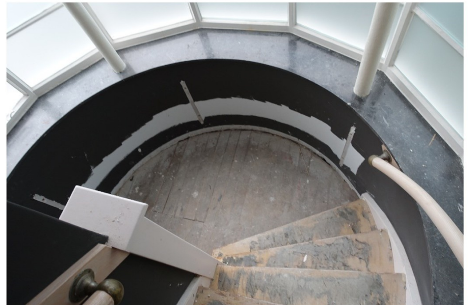
De natuurstenen vensterbanken in het trappenhuis (vertrek -1.11).
