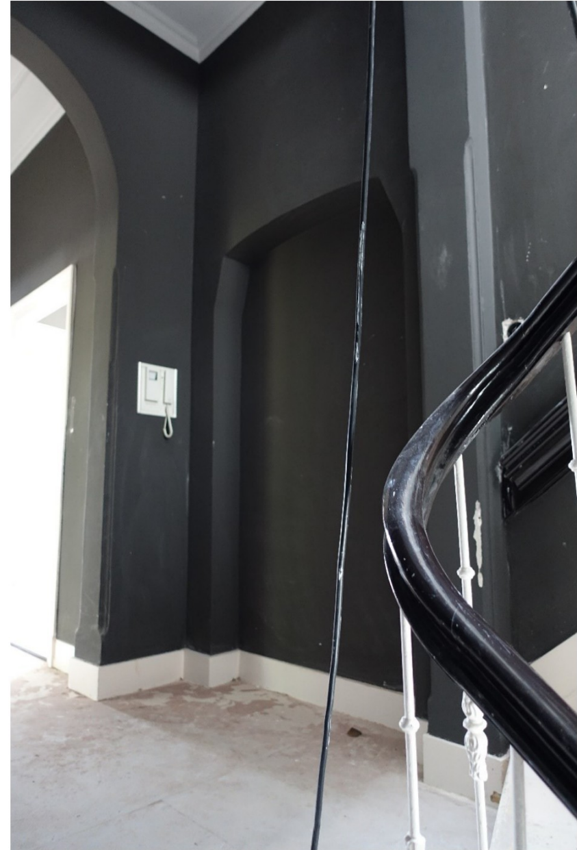
... en de dichtgezette doorgang naar de deels afgebroken aanbouw uit 1933.
