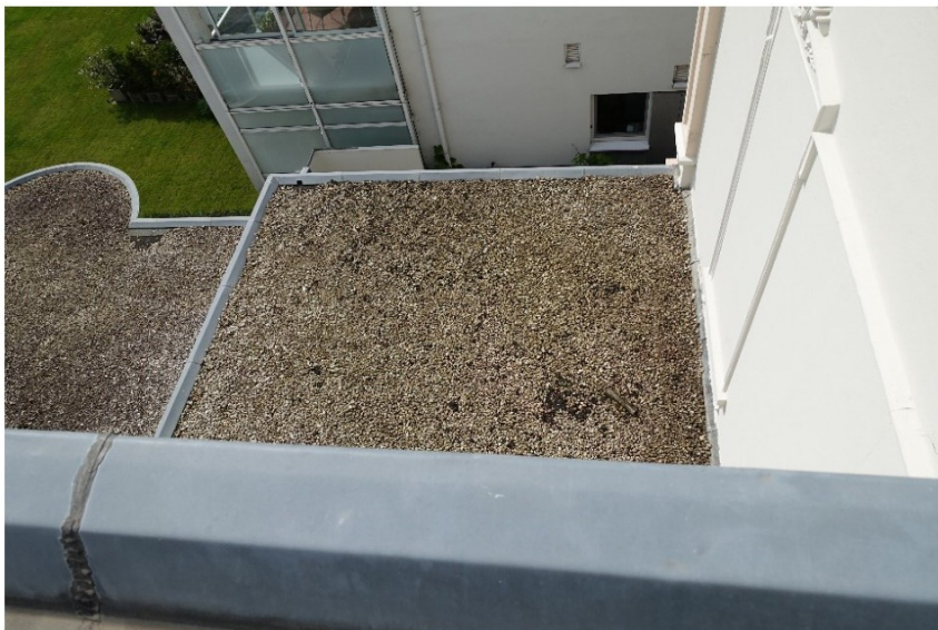
De dakbedekking met ballastgrind van de aanbouw uit 1938 (links) en de in de jaren 1990 verlaagde aanbouw uit 1933.
