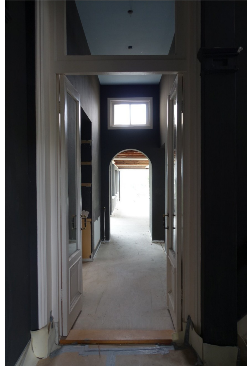
Vertrek 0.6, gezien vanuit vertrek 0.2. Links achter de linker deur is in de zijmuur een opening te zien. Die leidde oorspronkelijk naar de tuinkamer.
