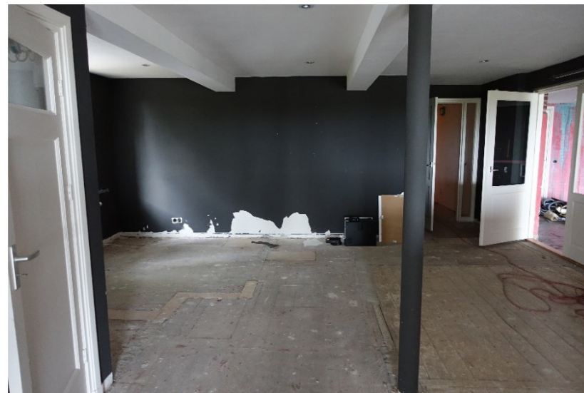
Het souterrain in de westelijke vleugel van de aanbouw. Een ronde stalen stijl draagt een balk waarop de vloer rust.
