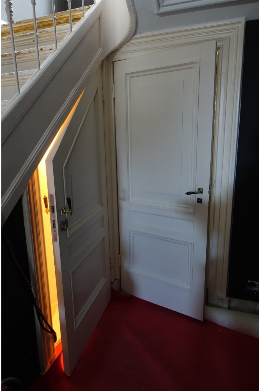
De deuren naar de keldertrap en naar het toilet.
