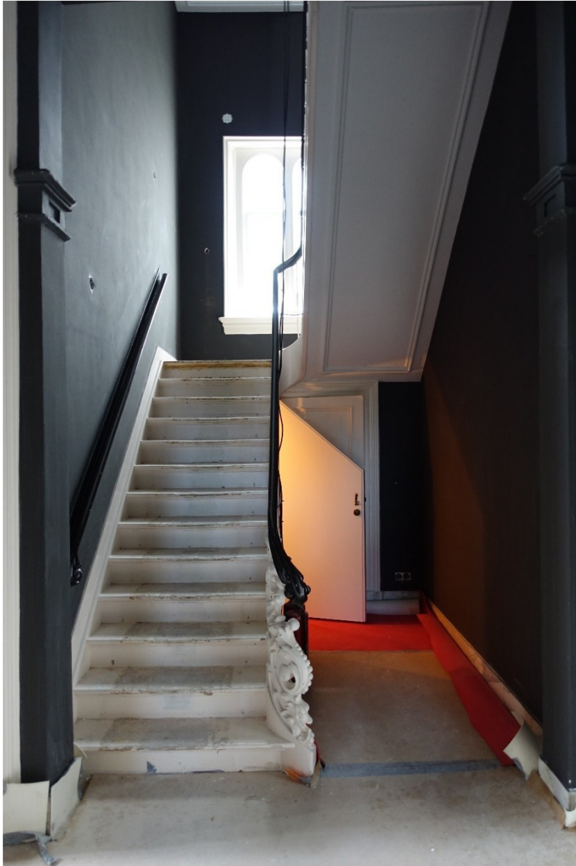
De trap, gezien in westelijke richting. De onderste trede buigt naar buiten af.
