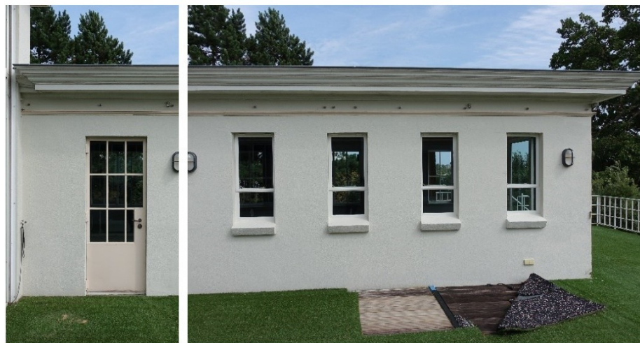
De rechter binnengevel van de begane grond.
