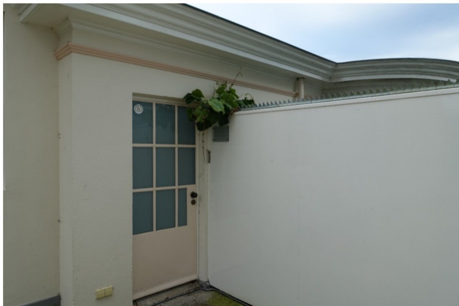
Het linker deel van de rechter zijgevel, met de modern vormgegeven stalen deur uit 1938. Achter de scheidingswand rechts ligt de tuin enkele meters lager.
