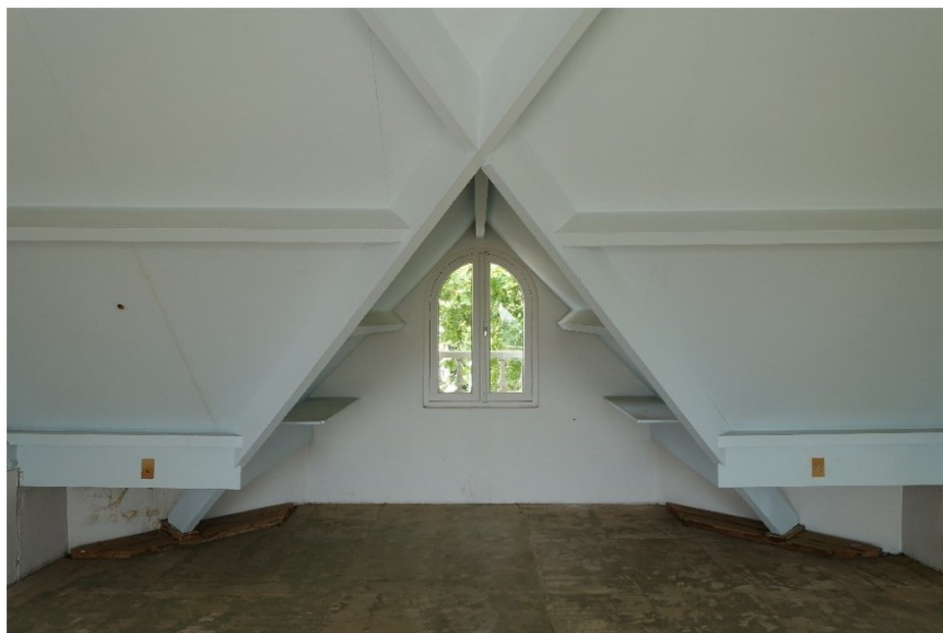
De steekkap van de topgevel.
