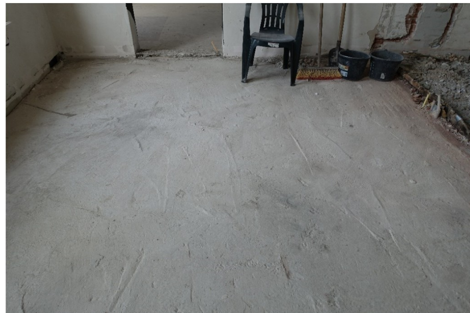
De dikke betonvloer op de eerste verdieping van de villa.
