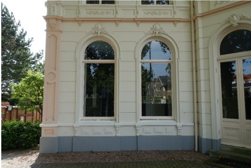
De rijk versierde gepleisterde gevel op de begane grond.
