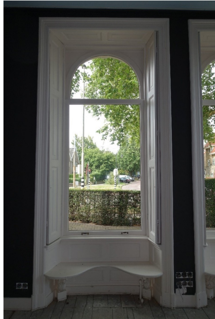
Een vensteropening in vertrek 0.3 met gepaneleerde betimmering, binnenluiken, geprofileerde omlijsting en vensterbanken op consoles.
