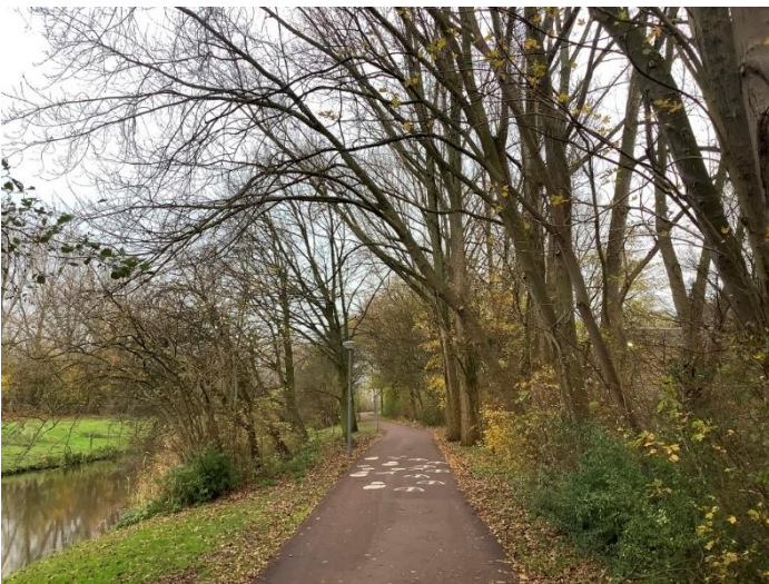
Foto links: boom 58 hangt scheef over fietspad. Door concurrentie naar het licht gegroeid en scheef gegroeid Foto rechts: uitgebroken kroondeel boom 104
