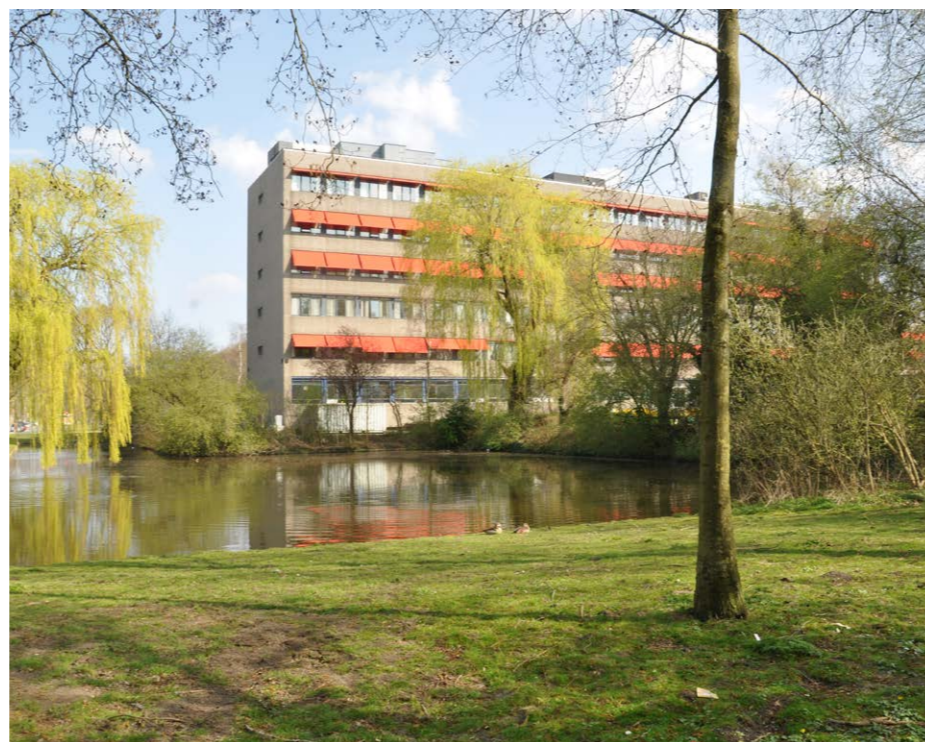
Renovatiegebouw Aafje Schiehoven en de plek waar de tuin aan het water zal grenzen met zicht over het landschap eromheen.
