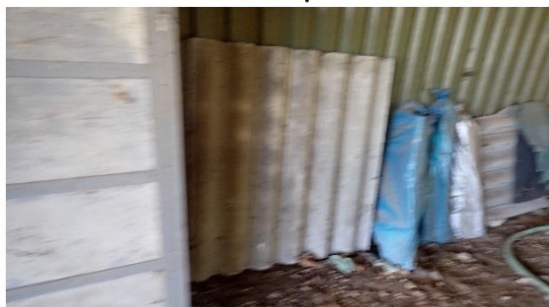
afbeelding 147: Foto golfplaten (NT) asbestvrij gelegen in de kapschuur
