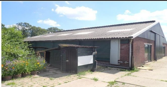
Foto 30 | Foto voor bron Golfplaten dak inclusief opzetstukken
