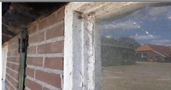
Foto 16 | Foto voor bron Stopverf (vaste ramen)
