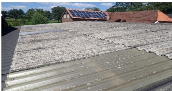
Foto 28 | Foto voor bron Golfplaten dak dakdeel 2
