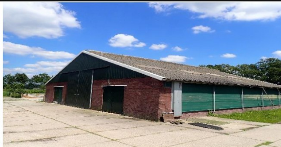
Foto 31 | Foto voor bron Golfplaten dak inclusief opzetstukken
