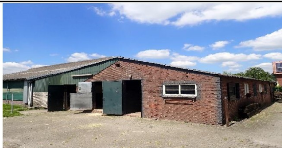
Foto 9 | Foto voor bron Golfplaten dak dakdeel 1
