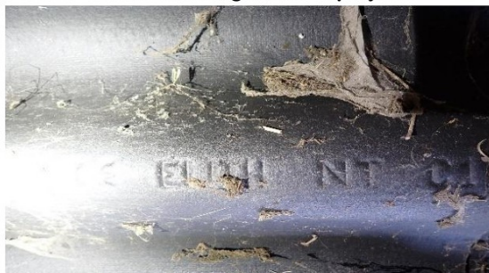
afbeelding 145: Foto golfplaten (NT) asbestvrij gelegen in de kapschuur
