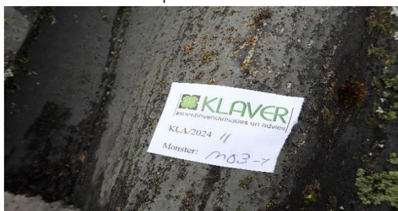
Foto 33 | Foto voor bron Golfplaten dak inclusief opzetstukken
