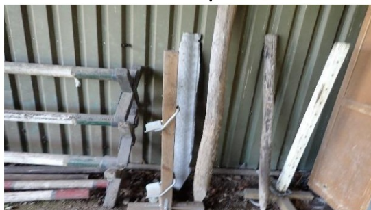
afbeelding 148: Foto golfplaten (NT) asbestvrij gelegen in de kapschuur
