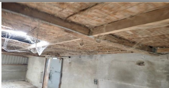
Foto 8 | Foto voor bron Golfplaten dak dakdeel 1
