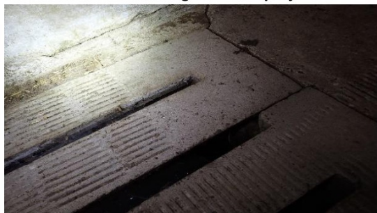
afbeelding 106: Foto inspectie in de mestputten
