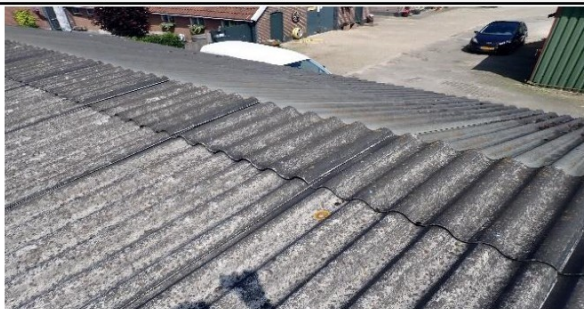
Foto 26 | Foto voor bron Golfplaten dak dakdeel 2
