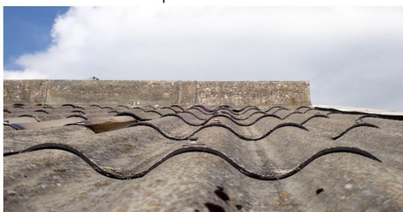
Foto 32 | Foto voor bron Golfplaten dak inclusief opzetstukken
