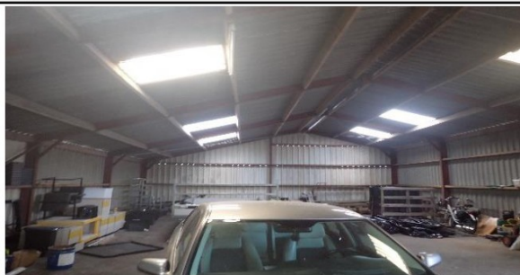
Foto 6 | Foto voor bron Golfplaten dak dakdeel 2
