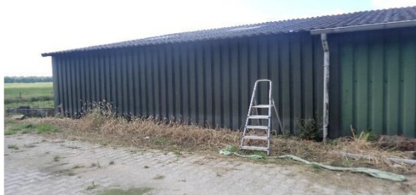
Foto 5 | Foto voor bron Golfplaten dak dakdeel 2
