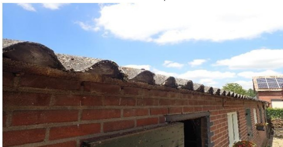
Foto 10 | Foto voor bron Golfplaten dak dakdeel 1
