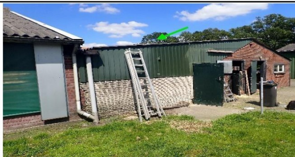
Foto 27 | Foto voor bron Golfplaten dak dakdeel 2
