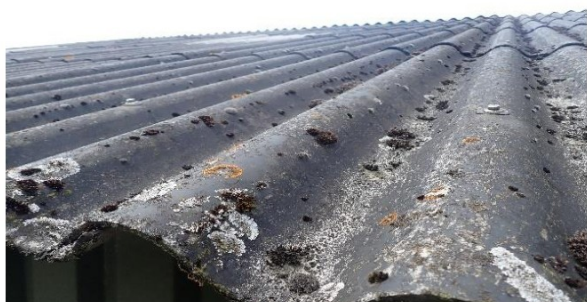
Foto 7 | Foto voor bron Golfplaten dak dakdeel 2
