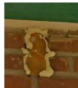
Openingen dichtgezet met pur
