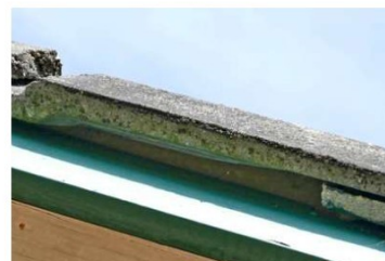
Kantpannen met toegangen
