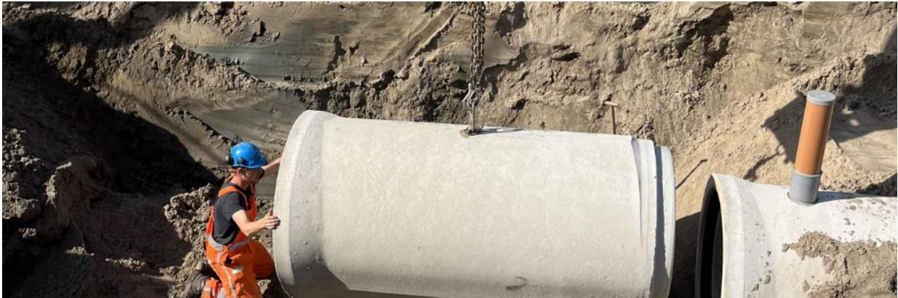
Figuur 4-3 Riolvervanging Oliemolenstraat Drachten [bron: https://www.witteveensurhuisterveen.nl/ ]
