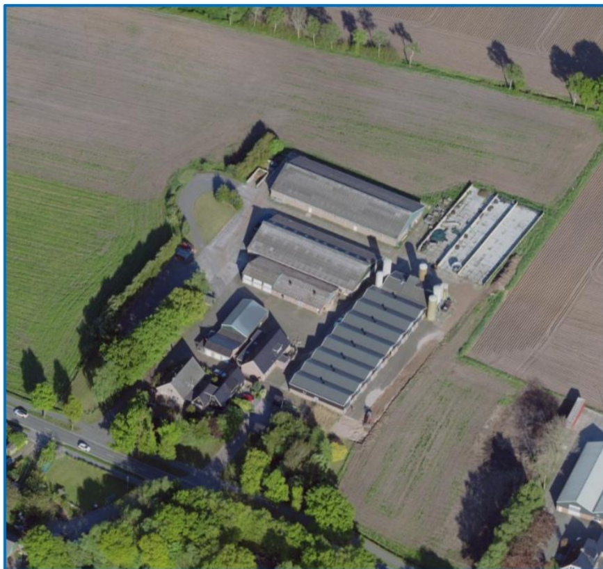
Figuur 1 Luchtfoto perceel Renswoudsestraatweg 21 te Lunteren (bron: Street Smart)
