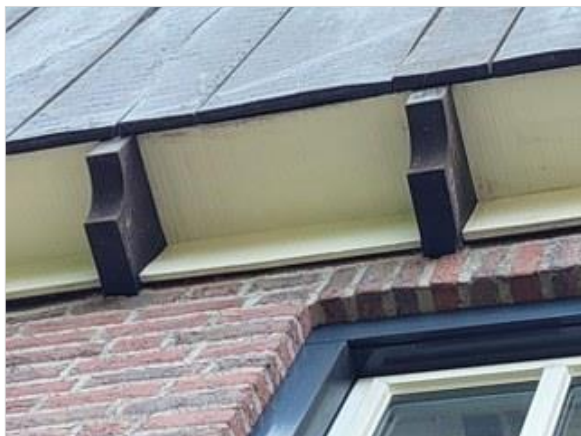
Figuur 4.9 Ruimte achter de gevelbetimmering voor vleermuizen.
