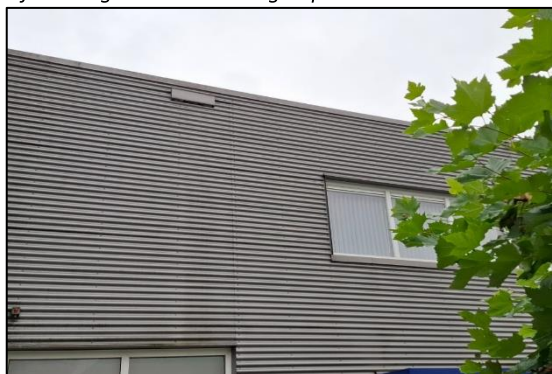
Afbeelding 2.5 Wanddelen zonder kieren of ruimte.
