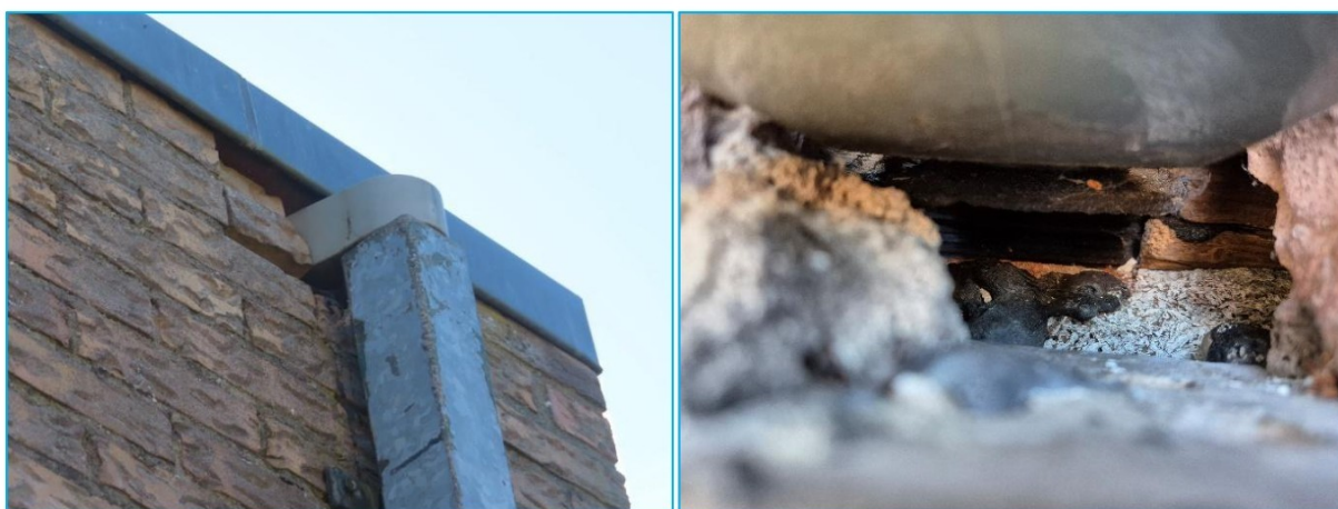
Foto's: Openingen rondom regenwaterafvoer.
