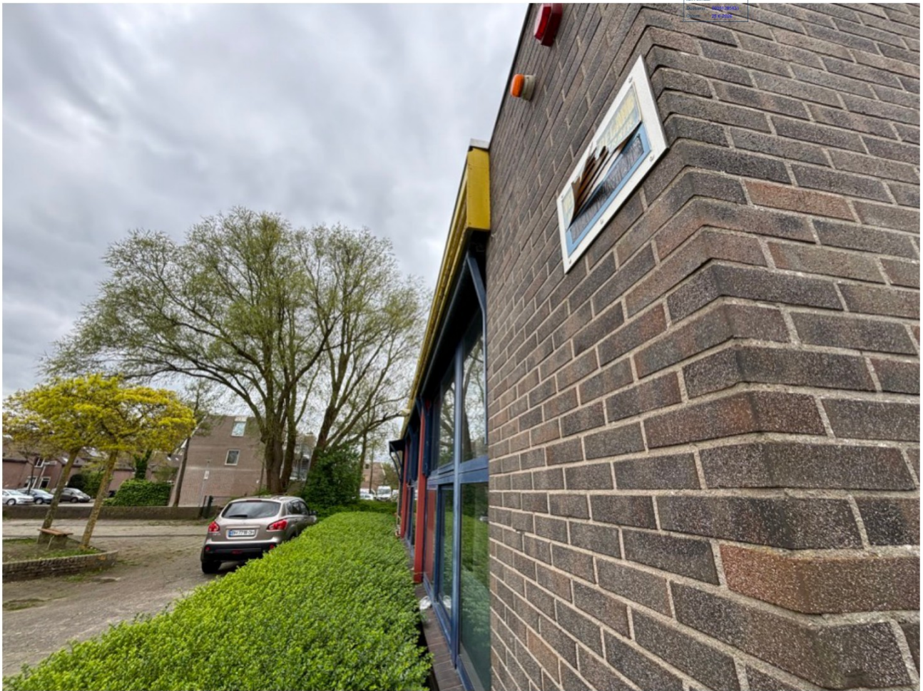
Afb.4: Foto van Rolluiken die geschikt zijn voor vleermuizen
