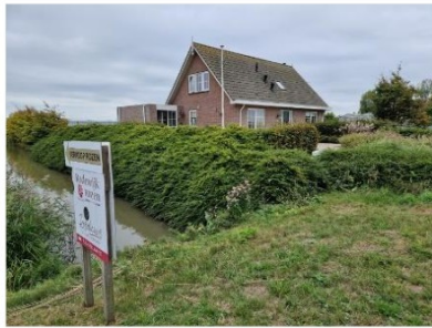
Figuur 5.1 Woning bij de Zonneveldselaan 9.
