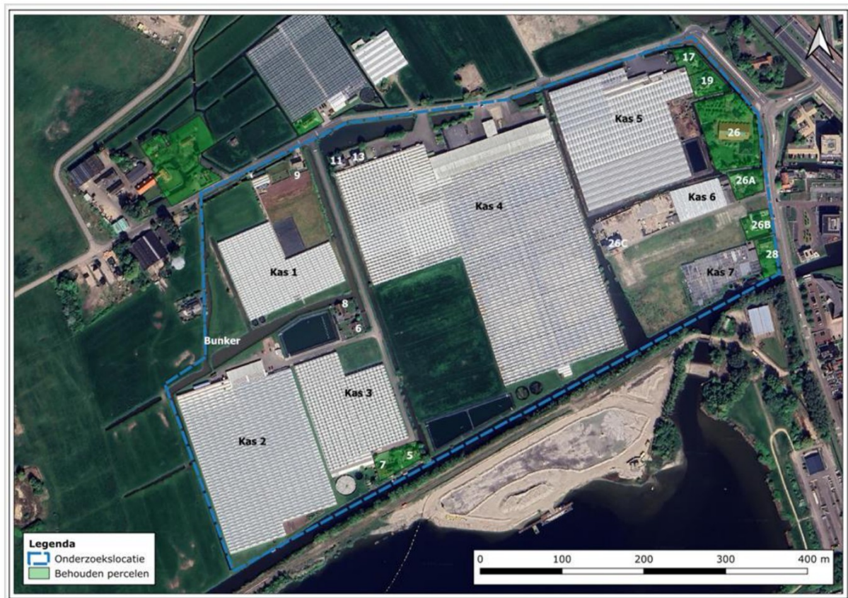
Figuur 2.3 Luchtfoto van de onderzoekslocatie met de te behouden percelen.
