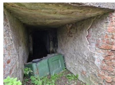
Figuur 5.9 Ondergrondse bunker op de onderzoekslocatie.
