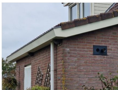
Figuur 5.8 Overhangende kantpannen bij de bebouwing op de onderzoekslocatie.
