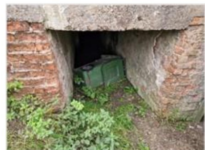
Figuur 2.6 Ondergrondse bunker aan de westzijde op de onderzoekslocatie.
