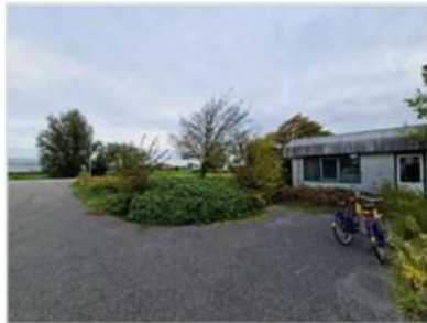
Figuur 2.7 Kantoorgebouw bij kas 4.
