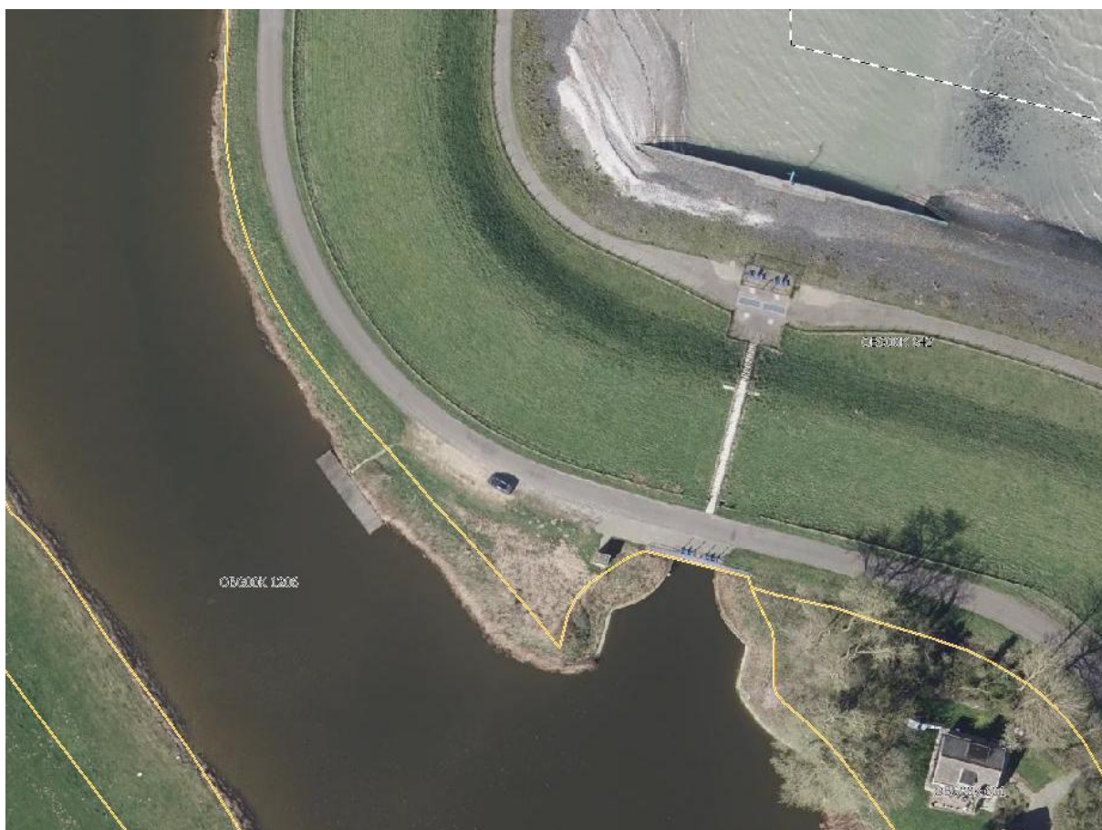
Figuur 1.3 Luchtfoto projectgebied (bron: Geoweb, waterschap Scheldestromen)
